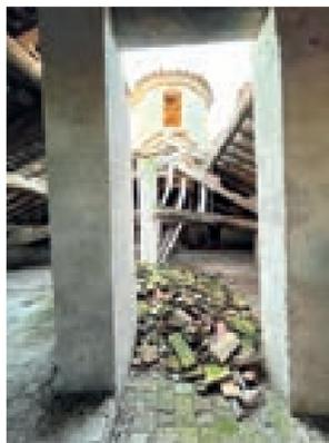
è crollata andando a gravare sul solaio sottostante, anch’esso realizzato in legno.
