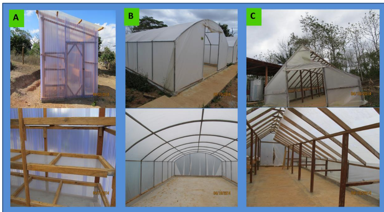
Figura No. 19. Fotografías mostrando tres técnicas de secado natural por medio de la utilización de casetas de secado y zaranda de fondo de alambre (A), túnel plástico sobre patio de secado (B) y (C) caseta plástica con zarandas de alambre con abertura en la parte superior del techo para permitir la salida de aire caliente y sirviendo para la regulación de temperatura. Fotografías Néstor Bonilla Bird.
