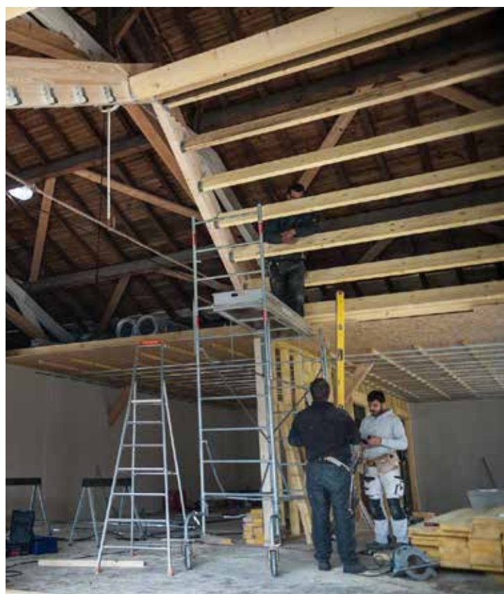
Quatre entités sont accueillies dans le Pôle écoconstruction de Beaulieu-lès-Loches. (Photo Sud Touraine Active)
