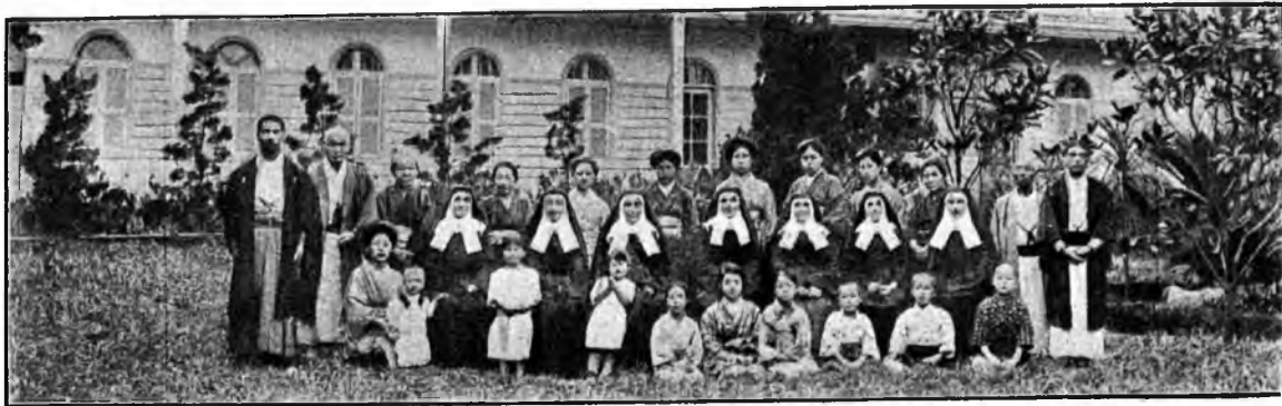
Les sept premières missionnaires de la Congrégation des Sœurs de Nevers installées à Tamatsukuri. 1922.
