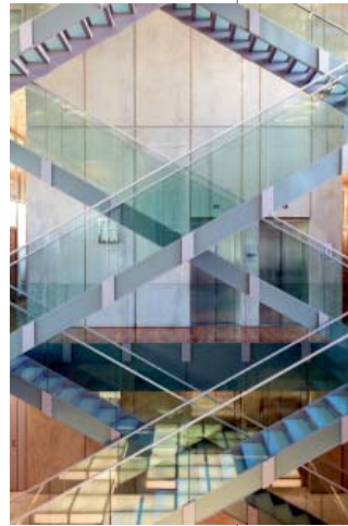
Das Treppenhaus mit Stufen und Geländer aus Glas (l.) entwarf der Schweizer Architekt Bernard Tschumi. Ein Aufzugsrotor wird heute rechnergesteuert poliert (unten).
