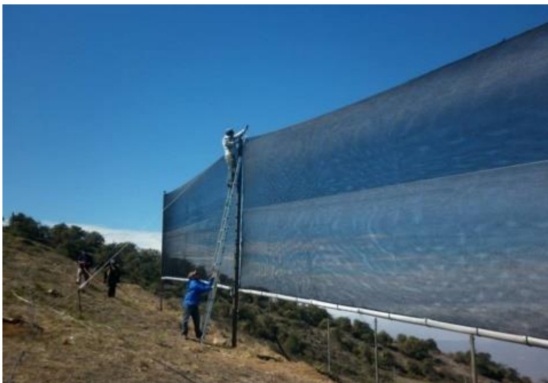
Figura 13. Sistema de atrapanieblas.
