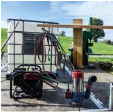
Abb. 08 - Leerer IBC-Tank auf dem Hänger. Die Tauchpumpe muss gegen ein Verdrehen gesichert werden.
