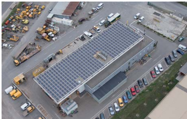
Fotovoltaikanlage auf dem Werkhofdach Bois-de-Bay in Onex im Kanton Genf.
