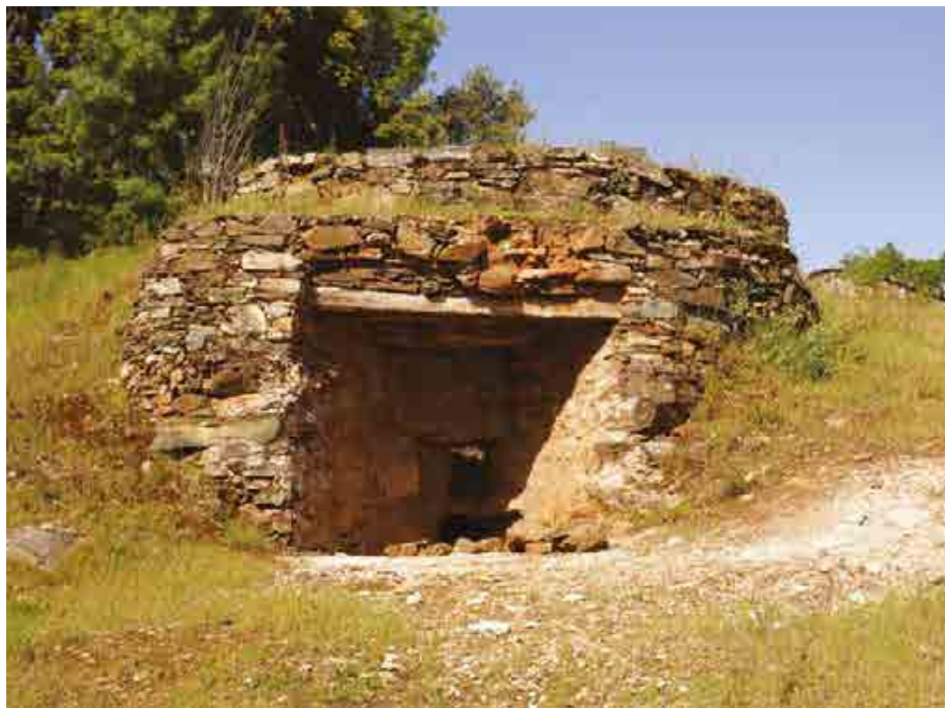
FIGURA 1 Fornos da cal em Dine. Os afloramentos de carbonatos foram tradicionalmente explorados para a produção de cal, um material de construção usado em argamassas e revestimentos. [Fotografia de Carlos Aguiar]
