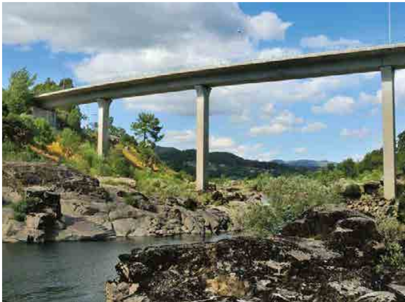
FIGURA 1 Ponte internacional de Melgaço sobre o rio Minho. [Fotografia de Paulo Ventura Araújo]
