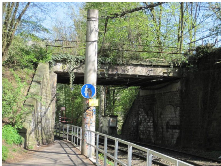
Stadtbahnlinie im Trassen- bereich, Blick nach Osten
