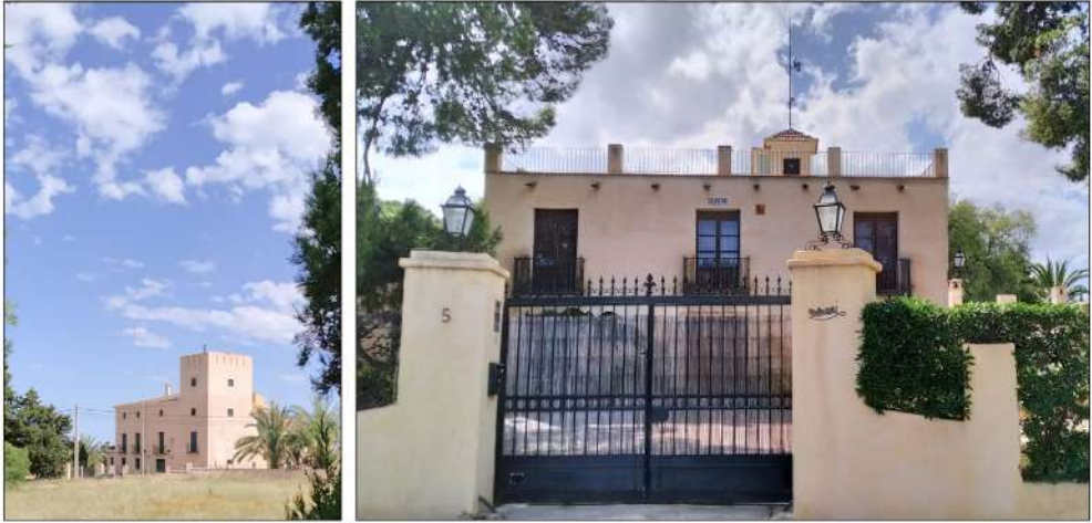
Figura 2. Vistas de la Torre Bonanza desde la casa de recreo El Serení (izquierda) y fachada de esta última (derecha). Fotografías del autor
