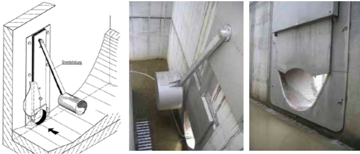
Abbildung 34 Hydroslide-Abflussregler, links: Skizze (Fa. Steinhardt), Mitte und rechts: HWRHB Urtlbach in St. Peter am Kammerberg: schwimmgesteuert: Einbau System Hydroslide; (aus: Perz, 2009 [14.]
