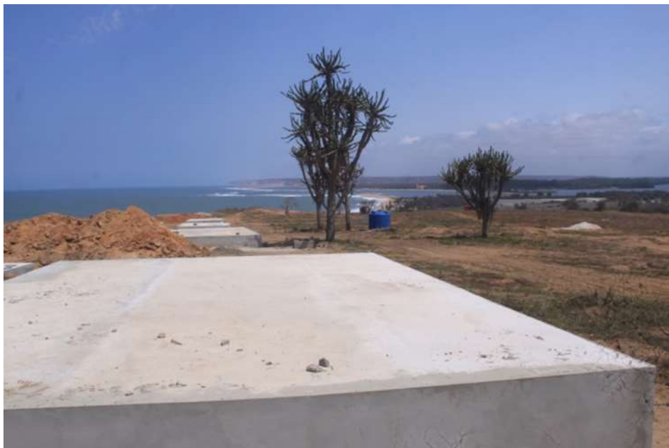
Foto 13. Fundações de um empreendimento, incompleto e imprevisto, com vista para a foz do rio Cuanza.
