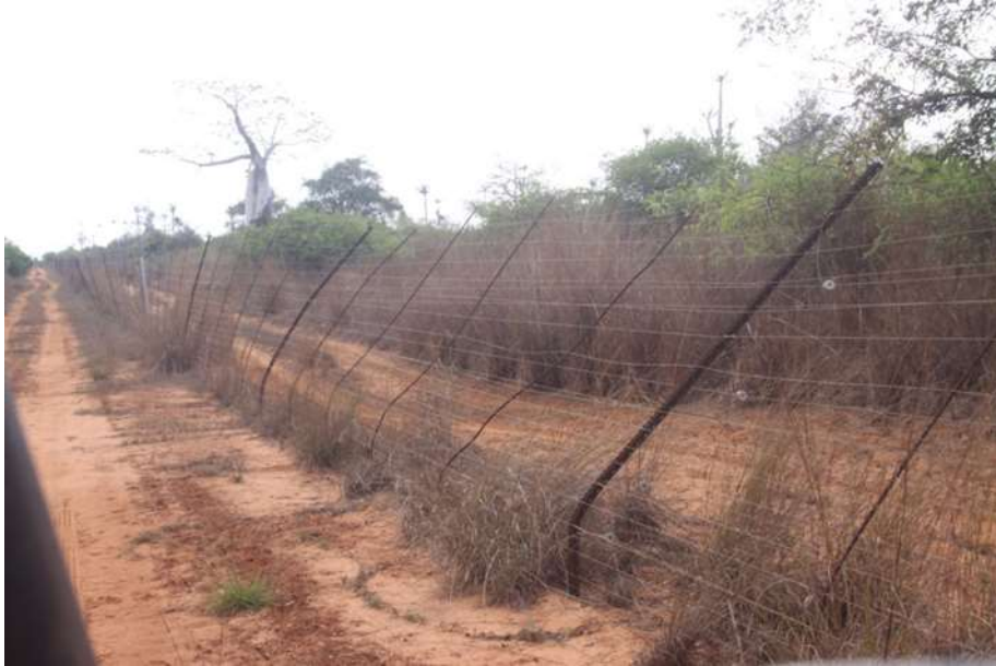
Foto 9. Perímetro da vedação da AEC (não tem sofrido nenhuma manutenção para a sua conservação).
