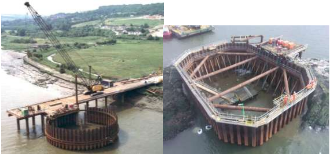
Ilustración 29 Recintos de tablestacas para ejecución de pilas de puentes.
