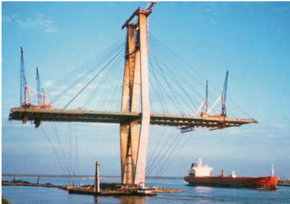
Ilustración 51 Ejecución de primeras dovelas con atirantamiento provisional inferior.
