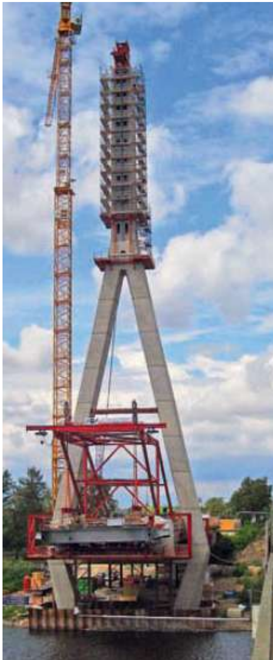
Ilustración 50 Ejecución de tramo superior con encofrado sobre camisa perdida
