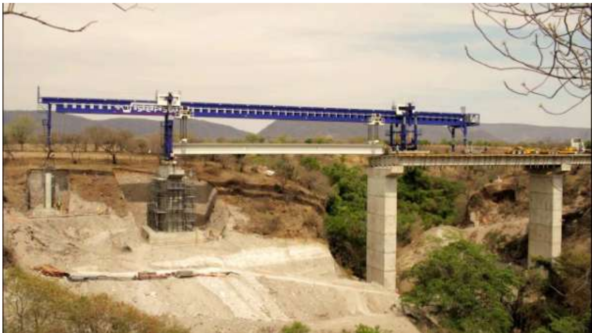
Ilustración 31 Lanzador de vigas prefabricadas.
