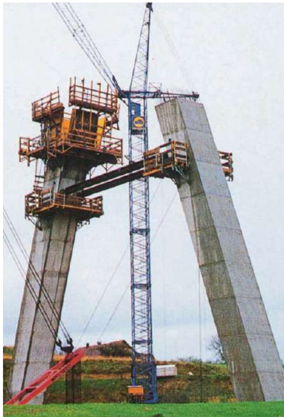
Ilustración 49 Ejecución de trepas y arriostamiento entre fustes
