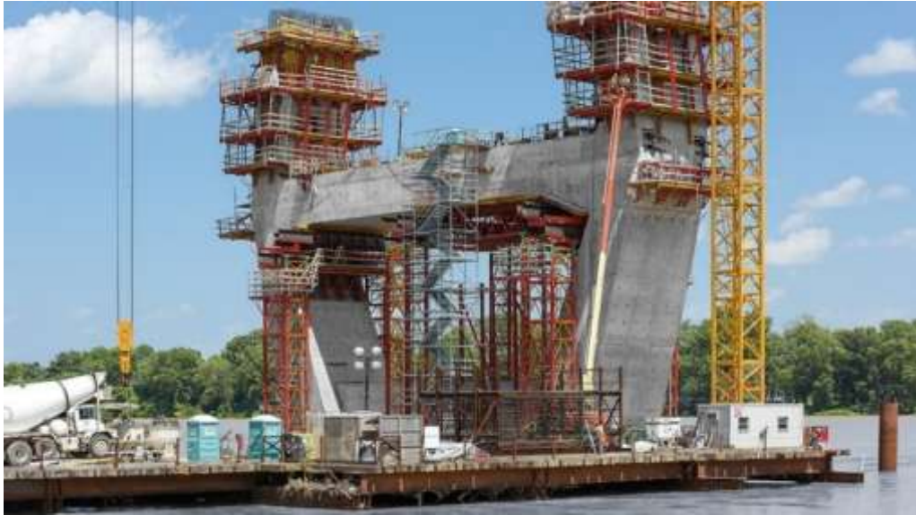
Ilustración 48 Ejecución de travesaño cimbrado y arranque de trepas de los fustes
