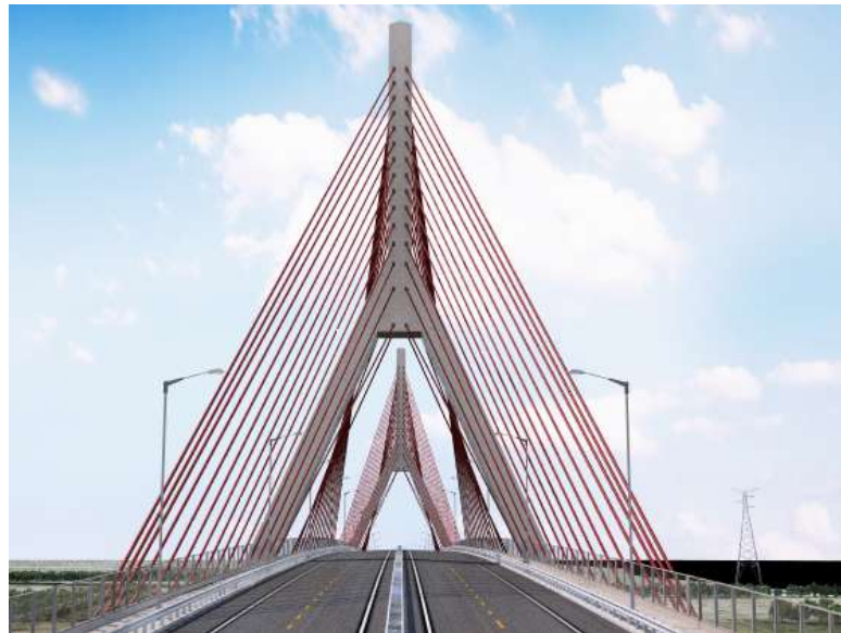
Ilustración 46 Vista del atirantamiento a borde del tablero desde las calzadas
