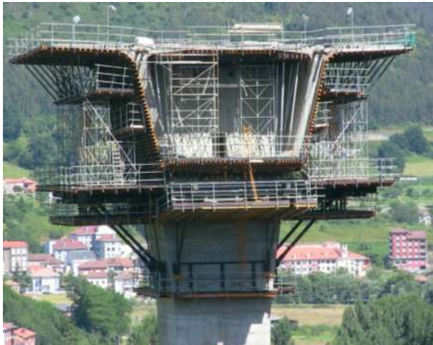
Ilustración 35 Ejecución de dovela 0 sobre pilas
