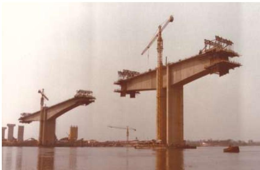
Ilustración 36 Ejecución por voladizos del Puente del Remanso.
