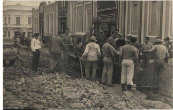
Comienzo de la instalación de agua corriente en Asunción año 1956 423
