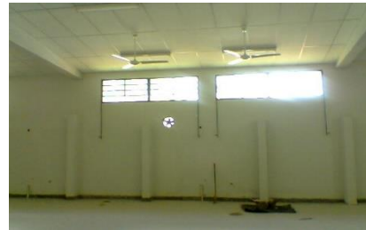
Parque Venezuela - Obras
