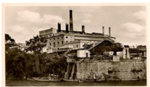
Central térmica. Edificio para el centro de 6kV
