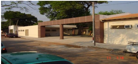
Hospital Distrital de Ñemby
