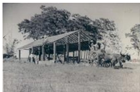
STICA año 1947. Construcción de hogares rurales 388
