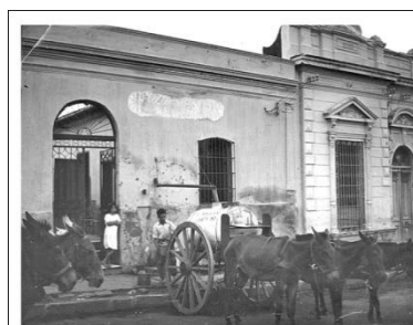
1942 distribución de agua potable
