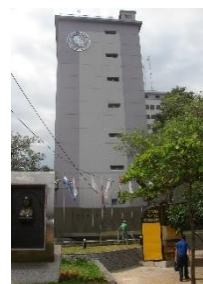
Edificio Central Administrativo del IPS
