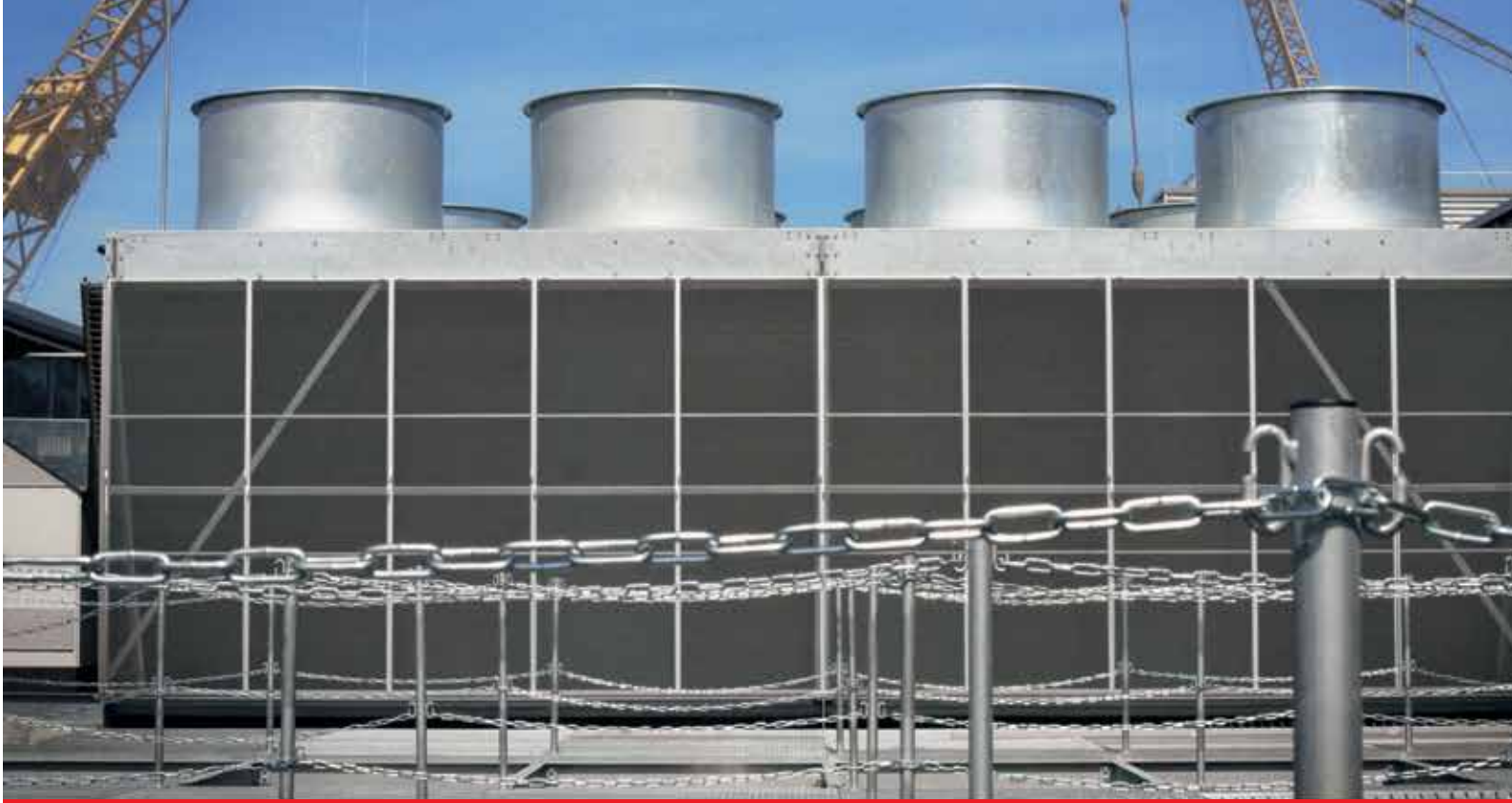
Tours de refroidissement (1,5 MW) pour centre de données
