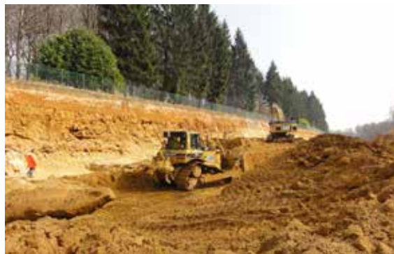
_Opération de terrassement dans la tranchée rocheuse située à hauteur du cimetière américain de Hamm
