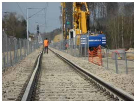
_Travaux réalisés au cours des périodes de barrage de week-end en 2014
