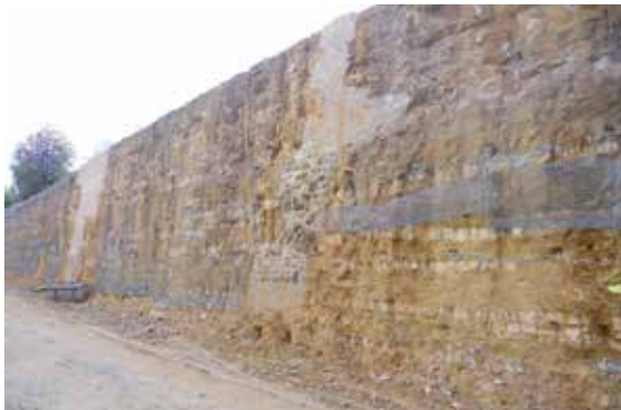
_Mise en place dans les nouvelles parois de fragments préalablement prélevés et stockés
