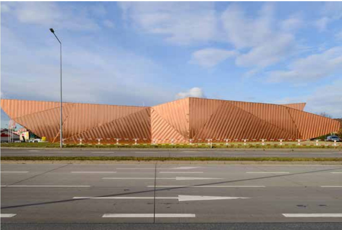
6_Toiture et façade en tôles de cuivre structurées d'épaisseur 0.8 mm du musée du feu à Zory (Pologne). Architectes: OVO Grabczewscy. © T. Zakrzewski
