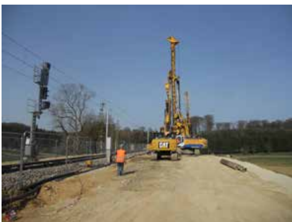
_Atelier de colonnes ballastées réalisées dans la zone de Scheidhof
