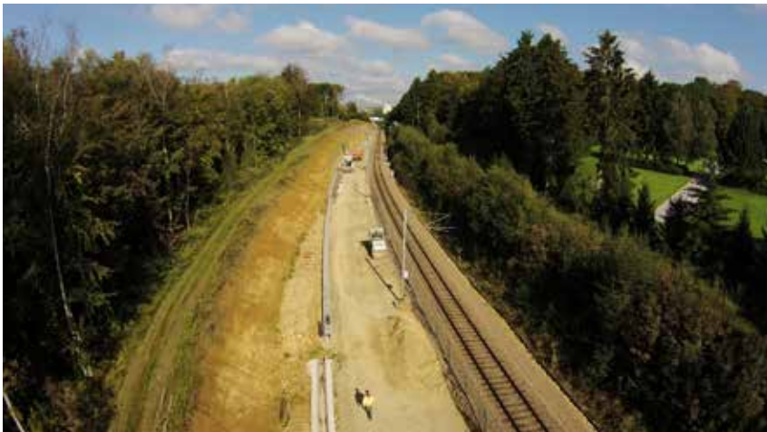
Zone de chantier à hauteur du cimetière américain de Hamm
