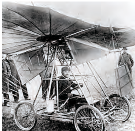
Figura 9. 22 Pe 18 martie 1906 la Montesson, lângă Paris, aparatul Vuia I a zburat pentru prima dată. După o accelerație pe o distanță de 50 de metri, aparatul s-a ridicat la o înălțime de aproape un metru, pe o distanță de 12 m, după care paletele elicei s-au oprit, iar avionul a aterizat. Traian Vuia (1872 - 1950).
