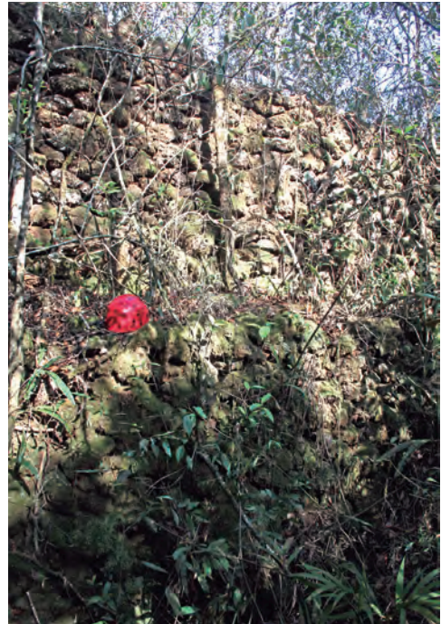
Figura 12 – Aqueduto de pedras com estrutura em escalonada que atravessa antiga cata aurífera
