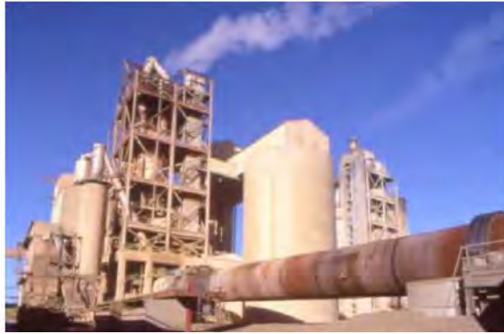
水泥窑和预热塔。图片来源于 Courtesy Castle 水泥厂, http://www.understanding-cement.com/manufacturing.html
