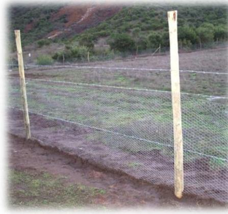
**Figura 42:** *Cerco con alambre hexagonal, alambre liso y alambre púa para protección de animales menores y mayores*
