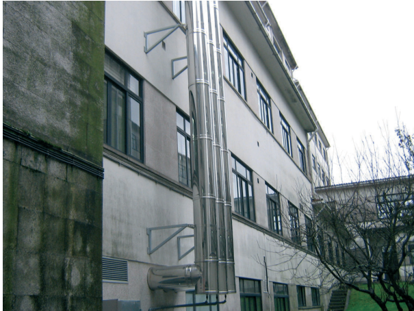
Nuevas chimeneas instaladas sobre la fachada.
