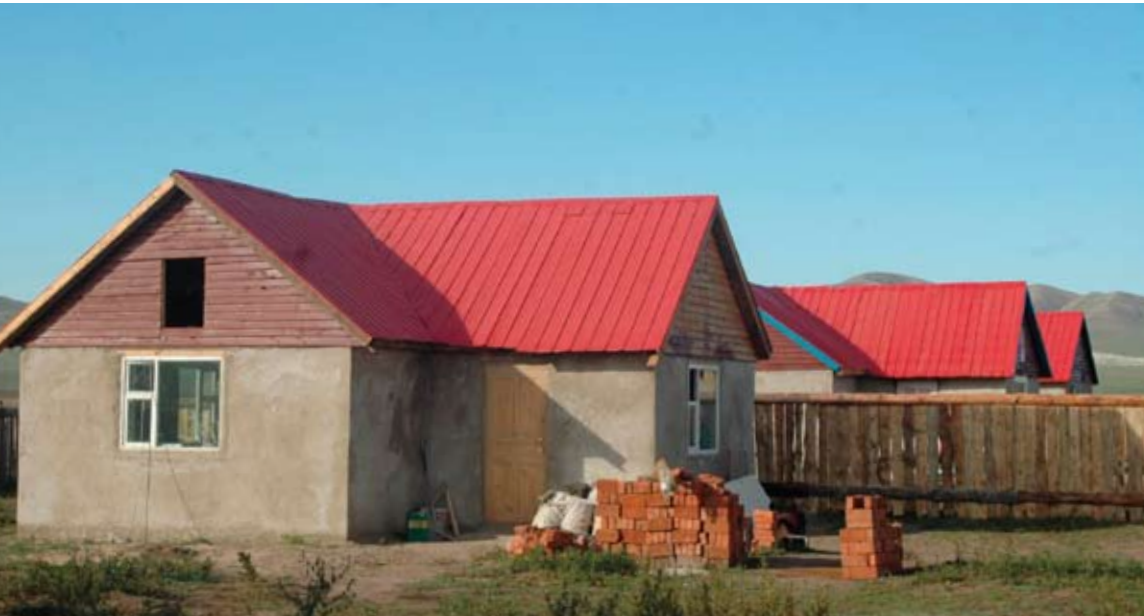
몽골의 해비타트 주택은 바닥과 벽 내부에 단열재가 장착된 조적식 주택이다
