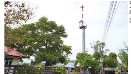
태국 푸켓 섬 반나이라이 마을에 설치된 재난 경보 사이렌
