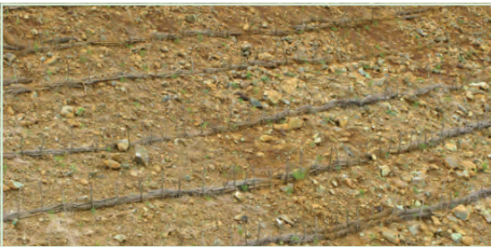
Figure 6.53 : Installation de fascines, entre bandes de plantation (mine Moulinet, Thio).
