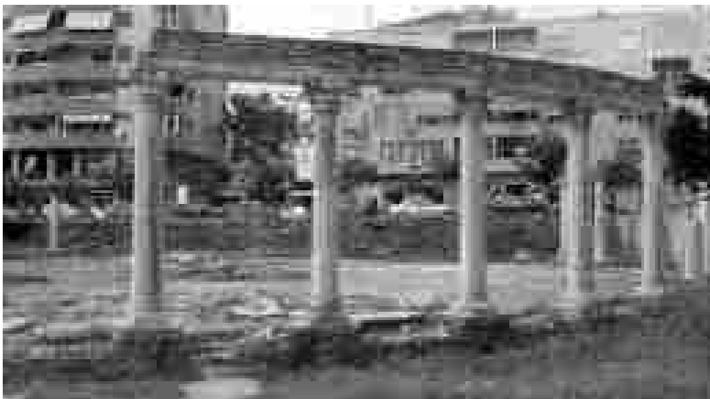
Fig. 5.4.14: Macellum-forum. Il settore Nord-Est del colonnato ricostruito nel 2003 con l'utilizzo di elementi originali e l'inserimento di una trabeazione in cemento armato (foto P. Baronio).
