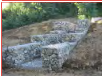
Opere di sostegno a gravità
