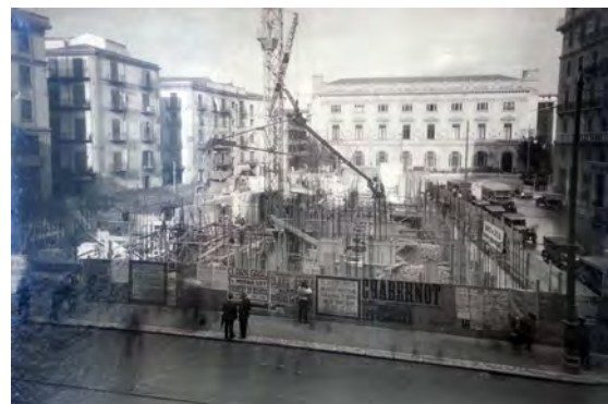
Figg. 139-140 S. Caronia Roberti, Progetto per la sede centrale del Banco di Sicilia di Palermo in via Roma, il cantiere durante i lavori di fondazione e le palificazioni Simplex, 5 ottobre 1934 , Fondo Caronia Roberti, Sezione fotografica, Collezioni scientifiche, Dipartimento di Architettura, Università degli Studi di Palermo
