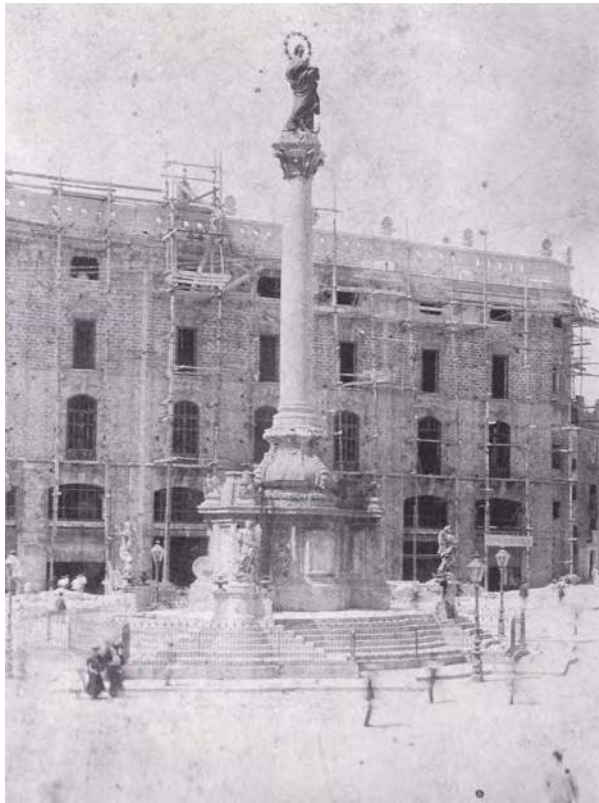
Fig. 6 A. Zanca, palazzo Paternò a Palermo, prospetto su piazza San Domenico in costruzione, 1906 ca. Fondo Zanca, Collezioni scientifiche, Dipartimento di Architettura, Università degli Studi di Palermo
