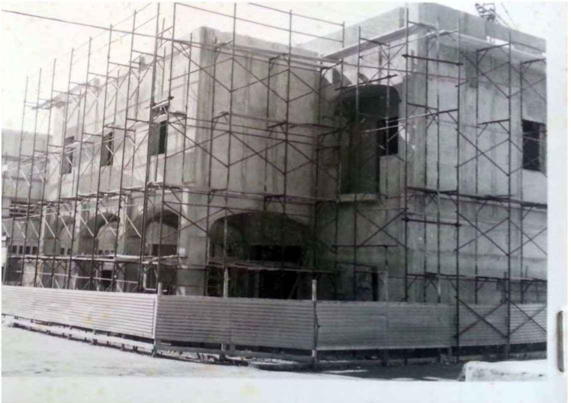
Fig. 202 V. Ziino, Progetto di ricostruzione postbellica dell'agenzia del Banco di Sicilia di Pantelleria, Edificio in costruzione, 5/4/1973, ASUIBSPA, Palermo
