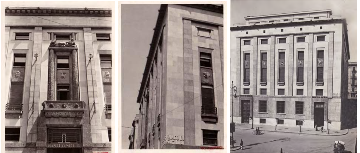
Figg. 160-161-162 Sede centrale del Banco di Sicilia di Palermo in via Roma, scorcio del prospetto, particolare dell'ingresso principale e prospetto su piazza Cassa di Risparmio, ASUIBSPA, Palermo
