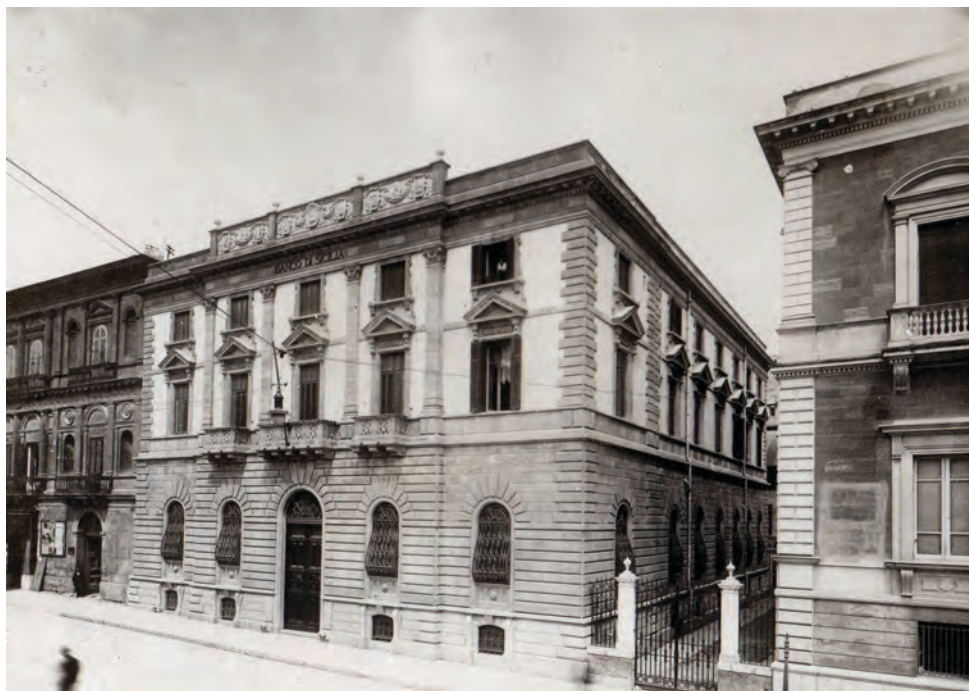
Fig. 37 Sede del Banco di Sicilia di Caltanissetta, Prospetto principale su corso Umberto I , ASUIBSPA, Palermo
