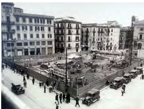
Figg. 139-140 S. Caronia Roberti, Progetto per la sede centrale del Banco di Sicilia di Palermo in via Roma, il cantiere durante i lavori di fondazione e le palificazioni Simplex, 5 ottobre 1934 , Fondo Caronia Roberti, Sezione fotografica, Collezioni scientifiche, Dipartimento di Architettura, Università degli Studi di Palermo
