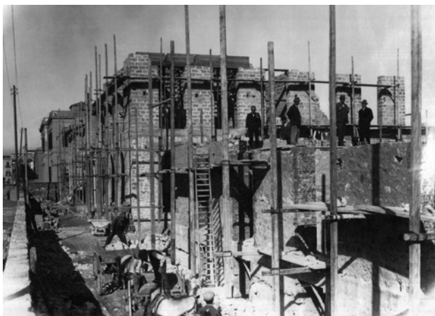
Fig. 35 Sede del Banco di Sicilia di Caltanissetta, cantiere di lavoro , Fondo Zanca, Collezioni scientifiche, Dipartimento di Architettura, Università degli Studi di Palermo
