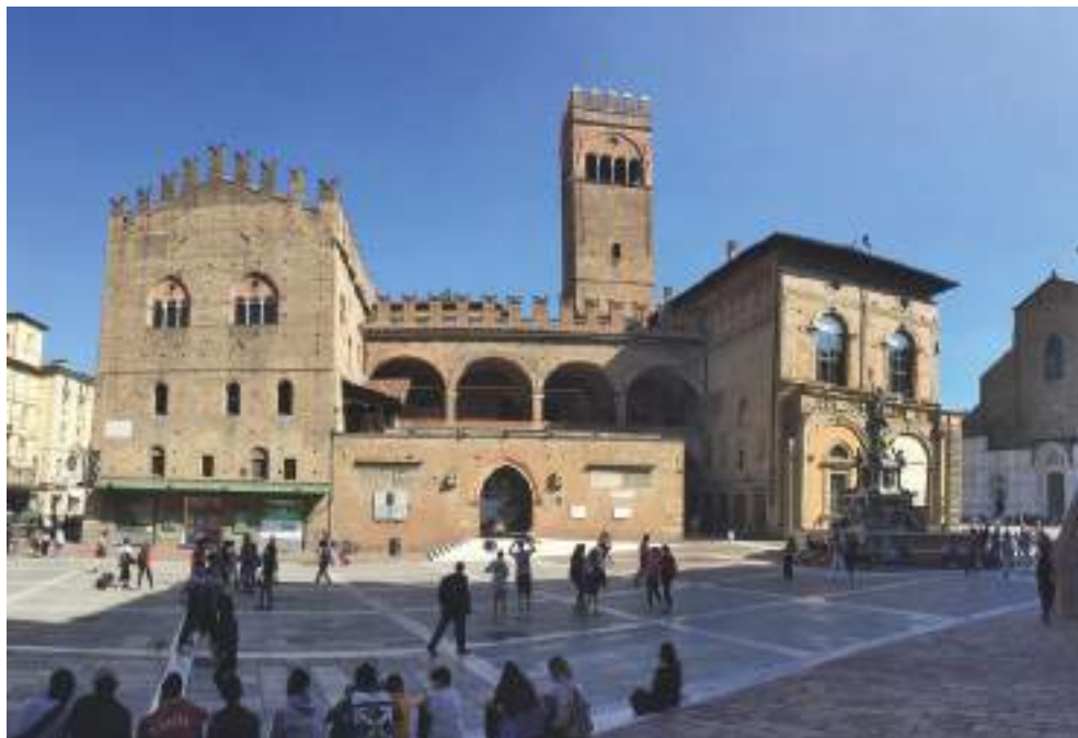
Fig.01 Bologna, piazza del Nettuno, progetto di pavimentazione e abbattimento delle barriere architettoniche, Panstudio architetti, 2016. M.G. Turco, 2019
