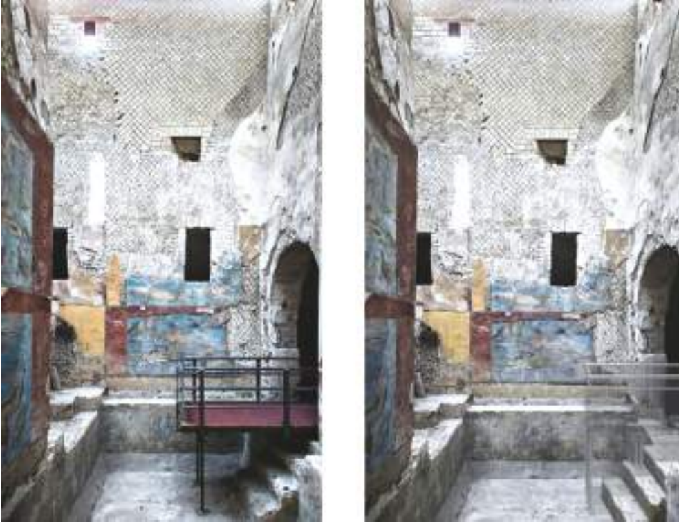
Fig. 05 La nuova passerella in acciaio e vetro strutturale e il tema della trasparenza. Confronto con la soluzione esistente.
