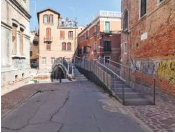
Fig.02 Ponte Ognissanti: vista della rampa a gradino agevolato sovrapposta al ponte realizzata nel 2015. La struttura della rampa, in lamiera pressopiegata in acciaio, segue il profilo della gradonata esistente su cui si appoggia rispettando in tal modo il criterio di reversibilità, oltre a caratterizzarsi per il suo aspetto formale. R.Revellini
