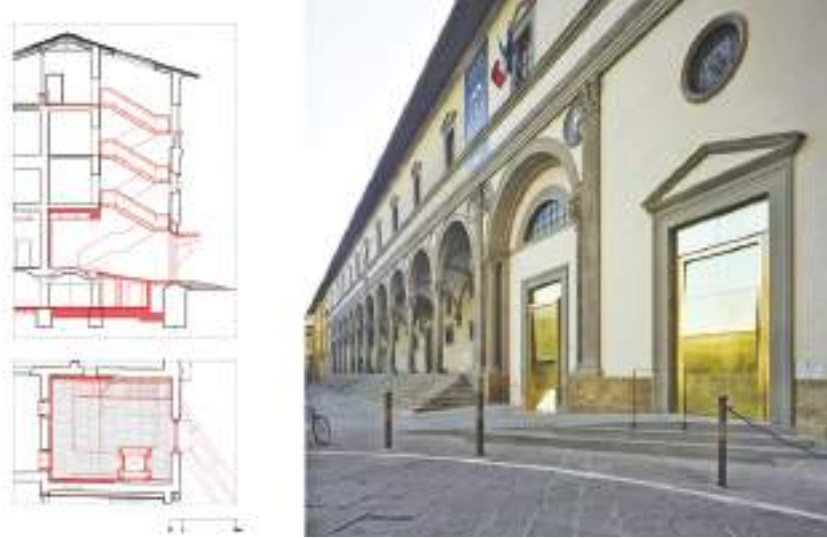
Fig.03 Le due porte di ingresso al sistema di servizi dello Spedale degli Innocenti (a destra, © Pietro Savorelli) e sezione dei collegamenti verticali (a sinistra, © Ipostudio architetti).
