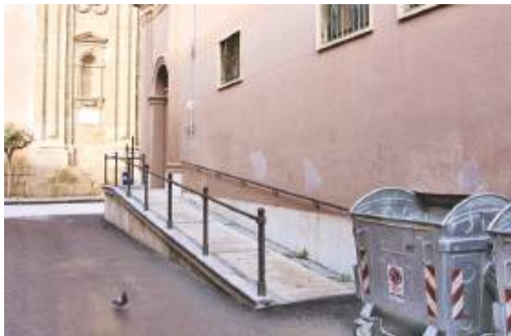
Fig.07 Rampa di accesso sul fronte laterale del Palazzo VII aprile (sede del Municipio) a Marsala (TP), realizzata secondo il principio dell'omogeneità morfologica con la preesistenza e aderente alla normativa tecnica: uno sforzo progettuale inficiato da una inaccurata gestione degli spazi pubblici (posizione cassonetti). M. Licari, 2007
