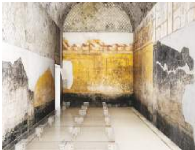
Fig. 04 La nuova passerella in acciaio e vetro strutturale: soluzione adatta alla lettura e alla conservazione delle pavimentazioni musive.
