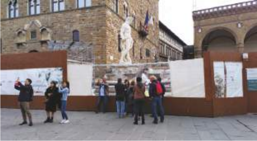
Fig.01 Restauri alla Fontana del Nettuno, Firenze (febbraio 2019). Il cantiere, circondato da pannelli riguardanti l'opera e gli interventi di conservazione, lasciava la possibilità di poter visionare direttamente questi ultimi, facendoli diventare un'occasione "social" di condivisione della cultura.
