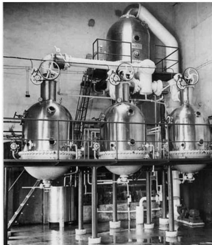
La pulizia da laboratorio che tanto colpì Piovene vista in questa foto d'epoca di un impianto a tre boules più preconcentratore nello stabilimento di Baiocchi, Valentini e Company a Carignano, Parma (per gentile concessione di Pier Luigi Longarini e Silva Editore, Parma).
