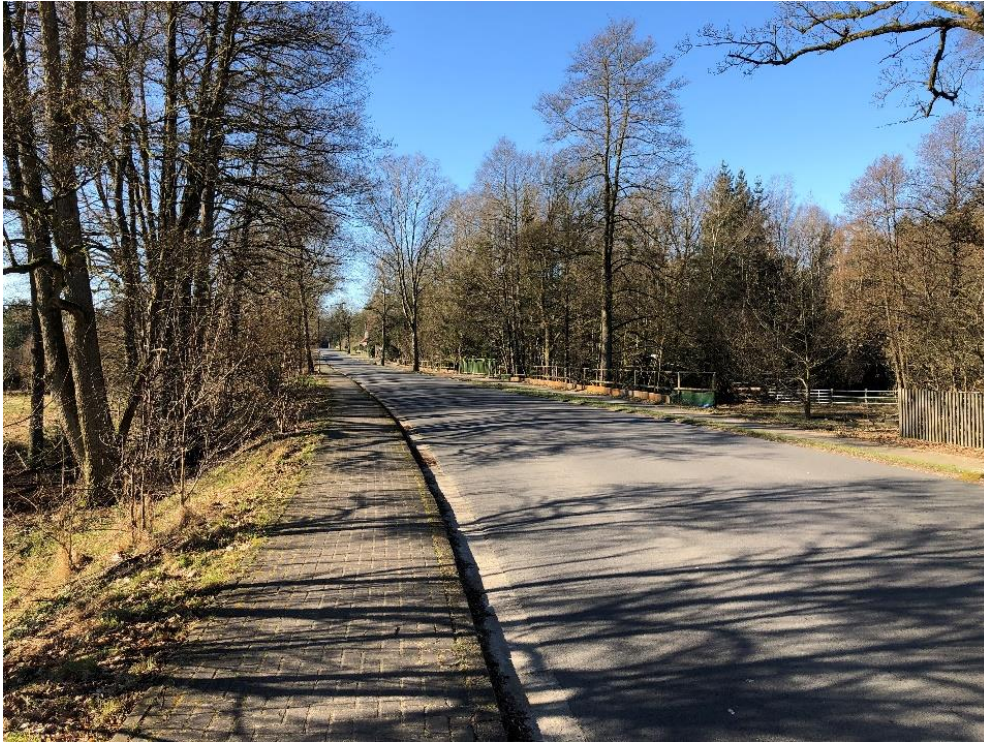
Abbildung 1: Ortsdurchfahrt Lutterloh. Quelle: Sweco GmbH
