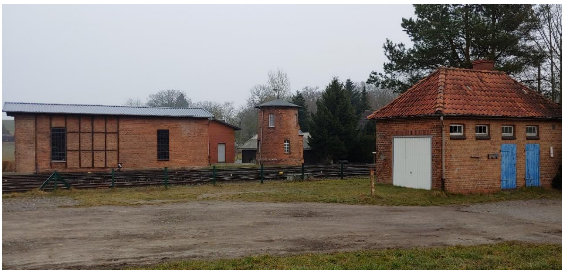
Abbildung 3: Bahnhofsgelände mit Gebäuden. Quelle: Sweco GmbH
