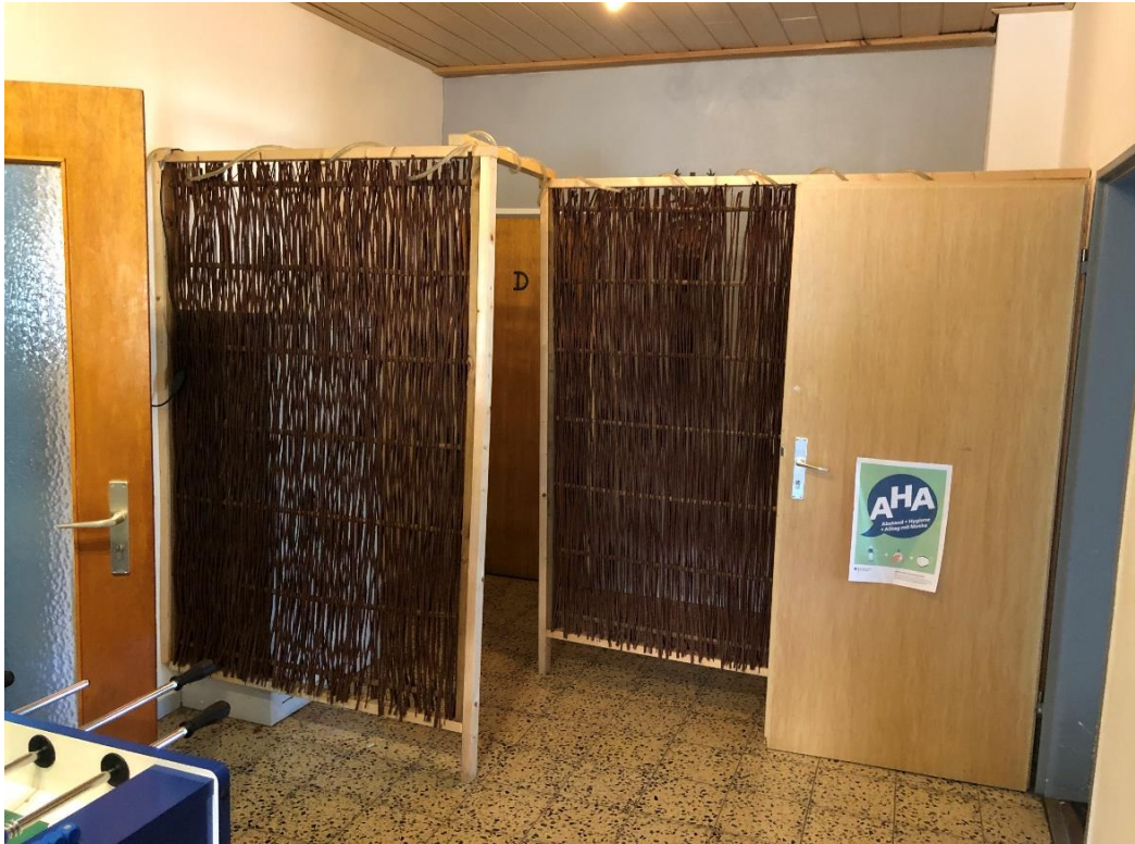
Abbildung 5: Toiletten im Dorfgemeinschaftshaus, Quelle: Sweco GmbH
