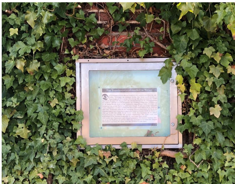
Abbildung 2: Bisherige "Informationstafel" an der Seite der Trafostation. Quelle: Sweco GmbH
