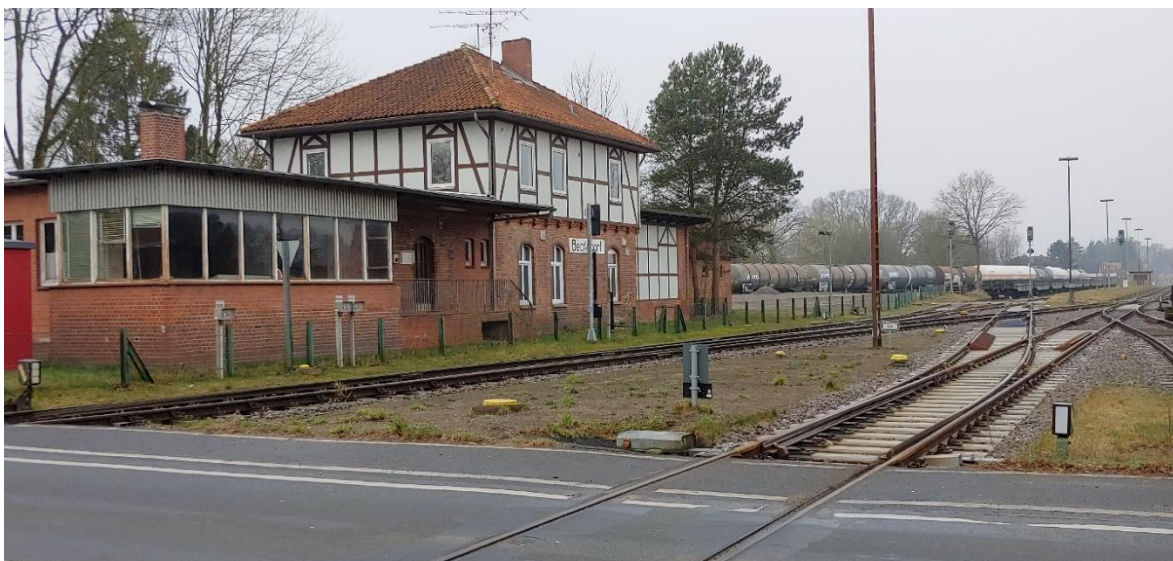
Abbildung 6: Bahnhof Gleisansicht. Quelle: Sweco GmbH
