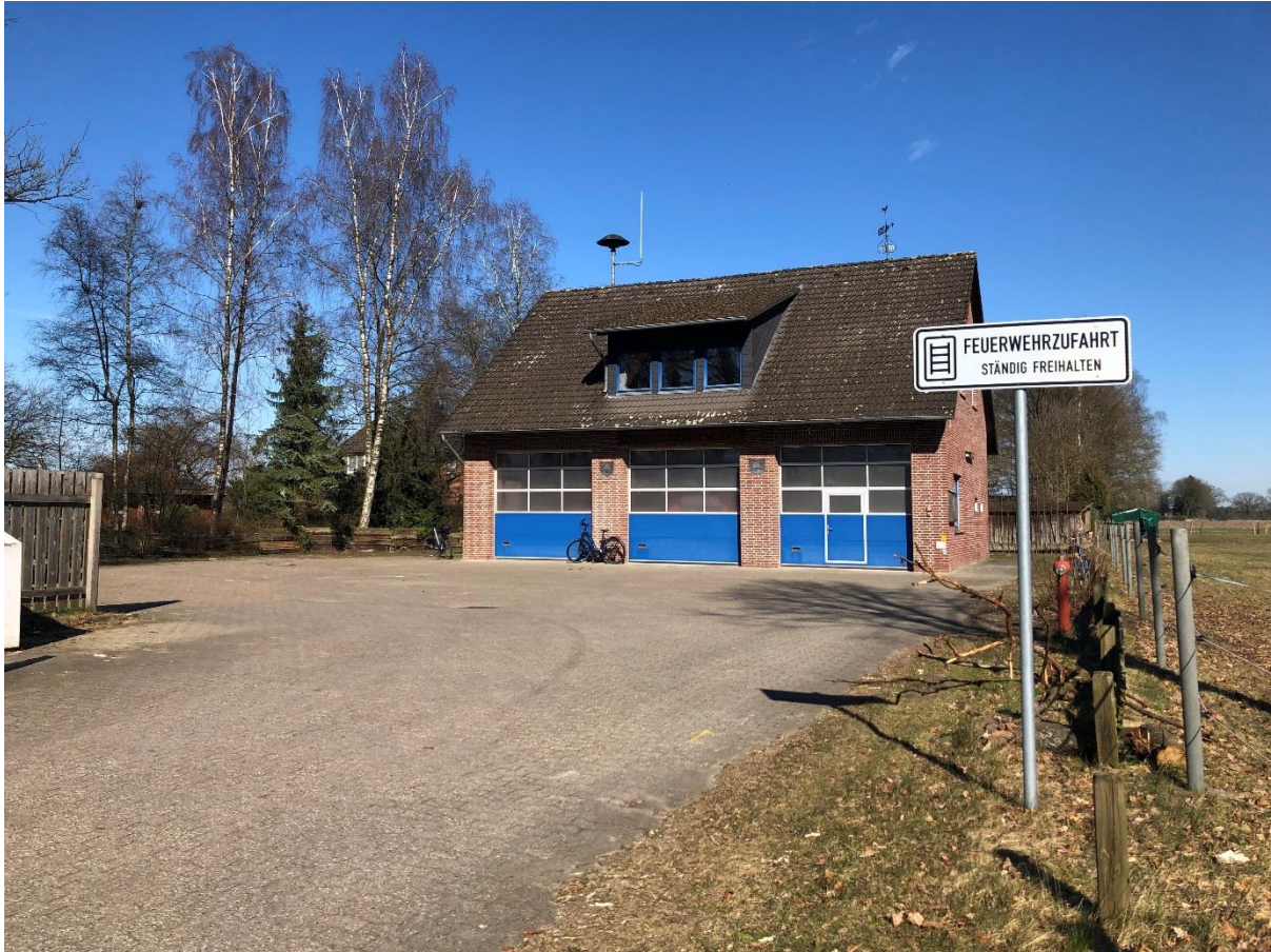
Abbildung 1: Feuerwehrhaus Weesen. Quelle: Sweco GmbH
