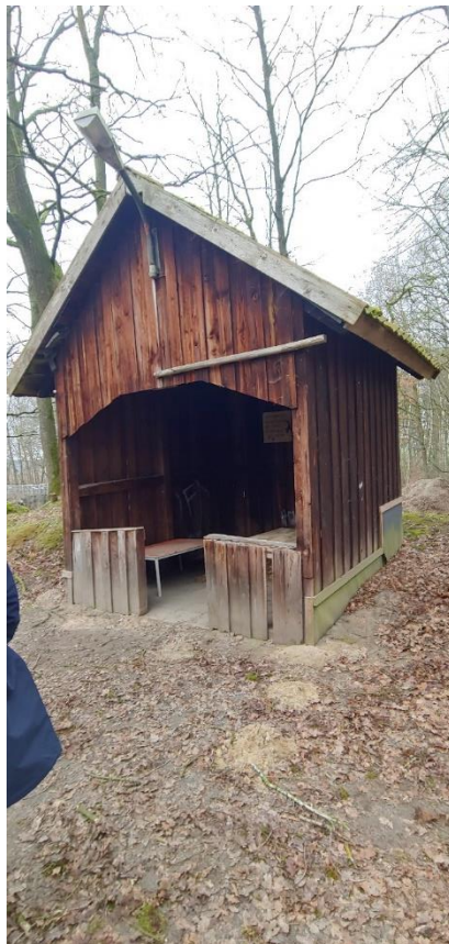
Abbildung 7: Zu sanierende Hütte. Quelle: Sweco GmbH
