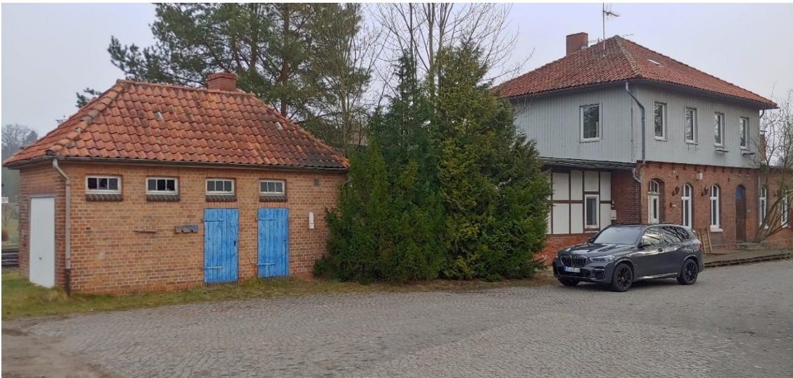
Abbildung 5: Außenansicht Bahnhofsgebäude. Quelle: Sweco GmbH
