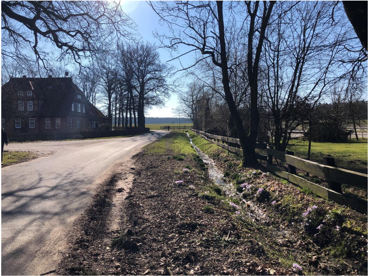
Abbildung 1: Entwässerungsgraben. Quelle: Sweco GmbH
