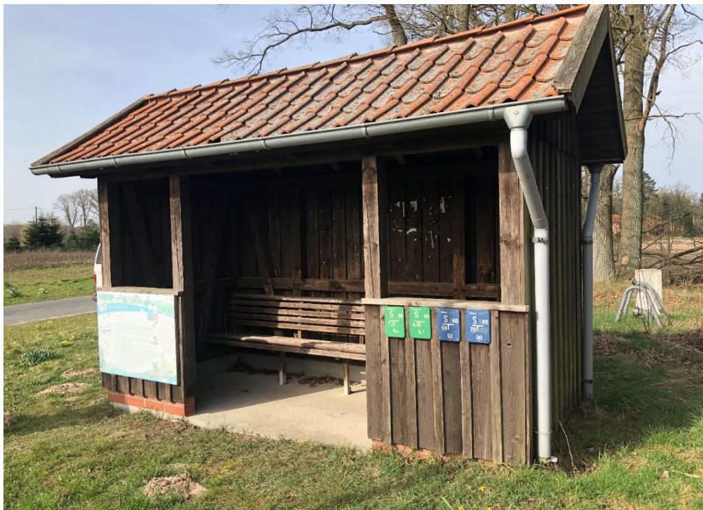
Abbildung 2: Bushaltestellenhaus Marbostel. Quelle: Sweco GmbH
