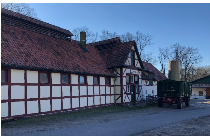
Abbildung 28: Ortsbildprägendes Gebäude in Lutterloh. Quelle: Sweco GmbH.
