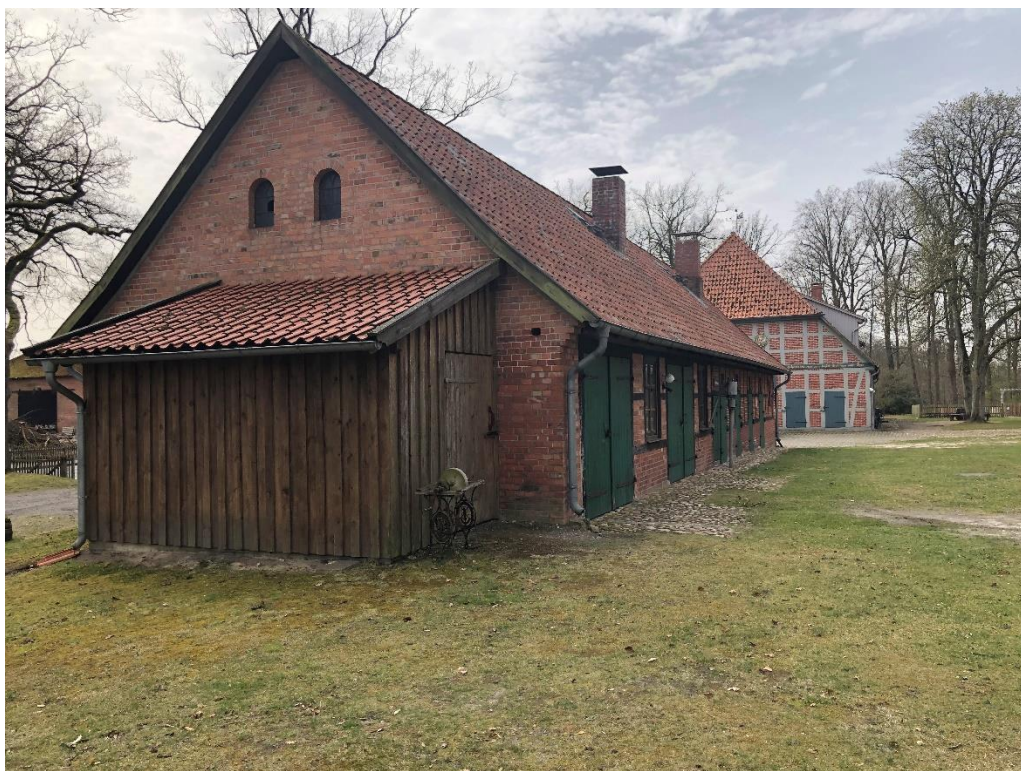
Abbildung 2: Schweinestall Rückansicht. Quelle: Sweco GmbH
