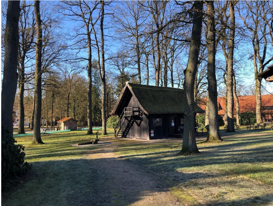
Abbildung 1: Treppenspeicher, Quelle: Sweco GmbH
