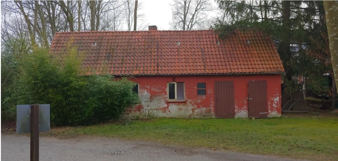
Abbildung 4: Gebäude auf Bahnhofsgelände. Quelle: Sweco GmbH
