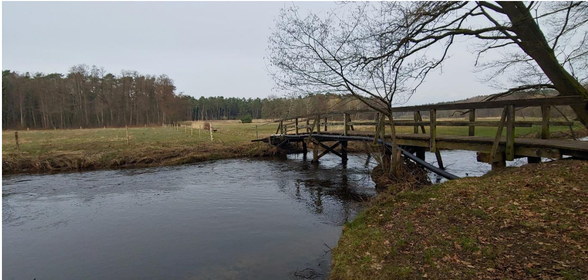
Abbildung 2 Brücke am Cmpingplatz Seitenansicht links. Quelle: Sweco GmbH
