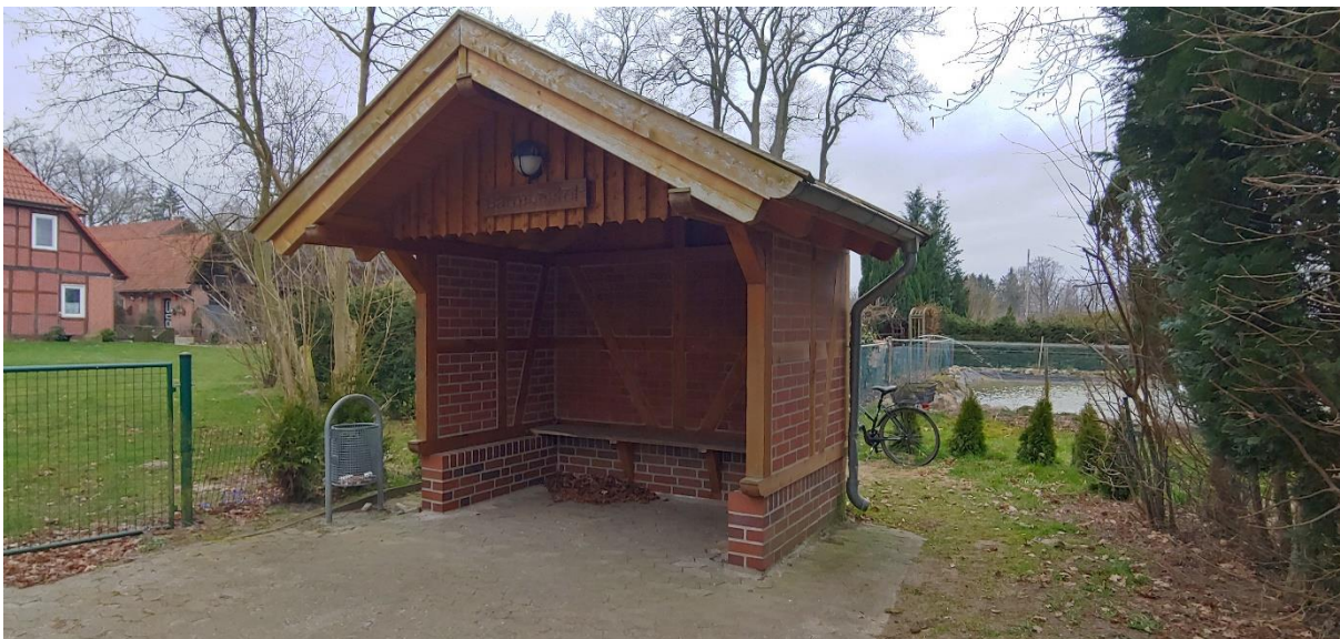
Abbildung 2: Bushäuschen, Quelle: Sweco GmbH
