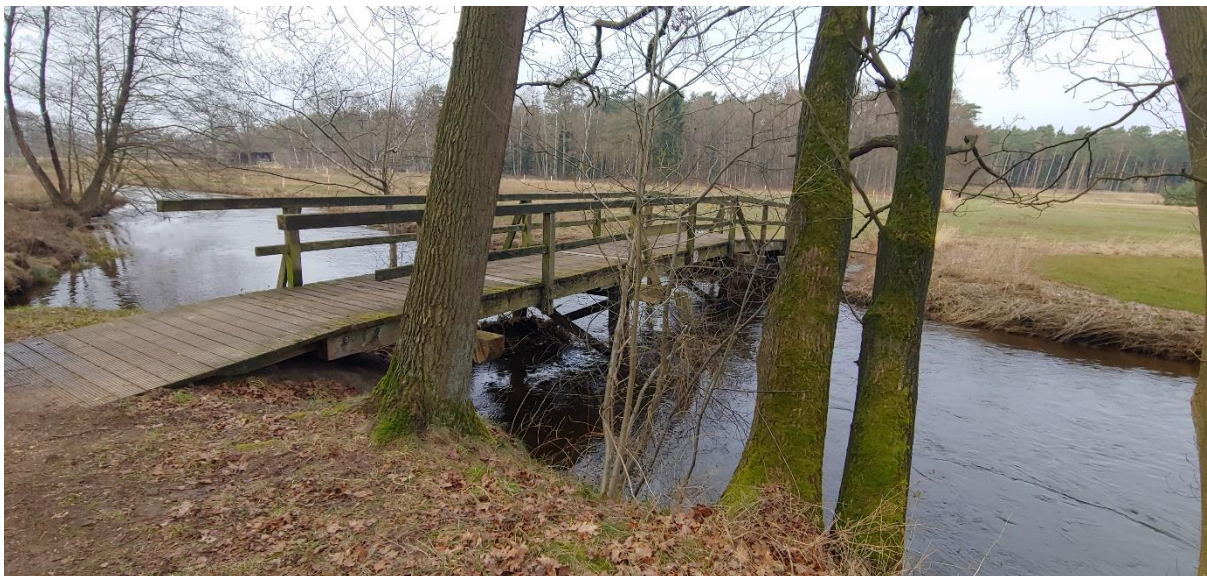
Abbildung 3: Brücke am Campingplatz Seitenansicht rechts. Quelle: Sweco GmbH
