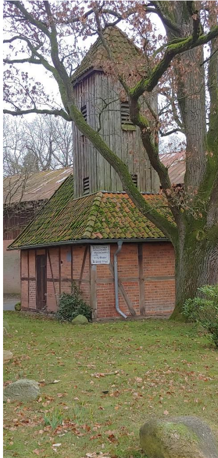
Abbildung 5: Spitzhausl. Quelle: Sweco GmbH
