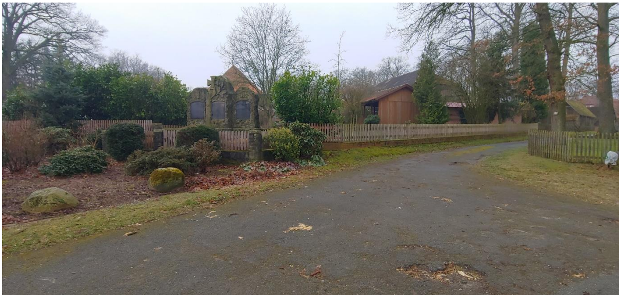
Abbildung 2: Denkmal Weitansicht. Quelle: Sweco GmbH
