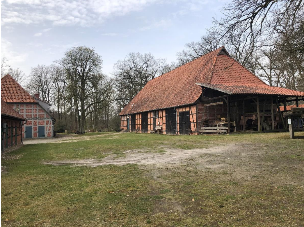
Abbildung 3: Gebäudearrangement Peetshof. Quelle: Sweco GmbH
