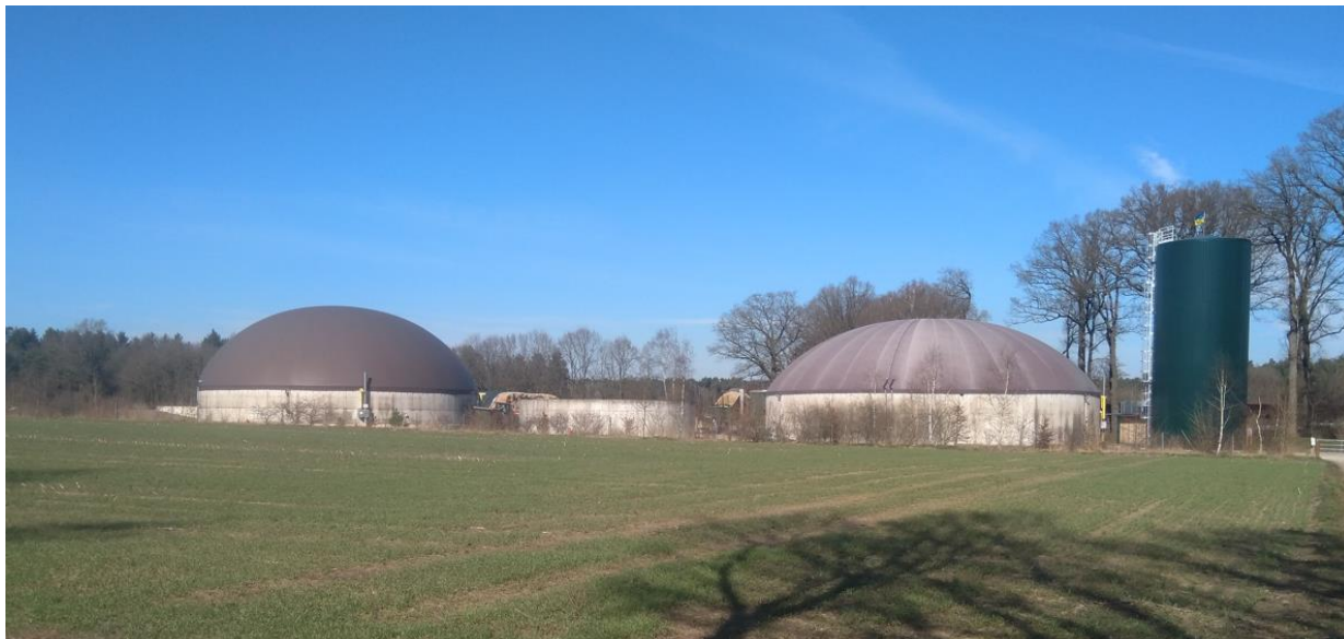
Abbildung 73: Biogasanlage. Quelle: Sweco GmbH
