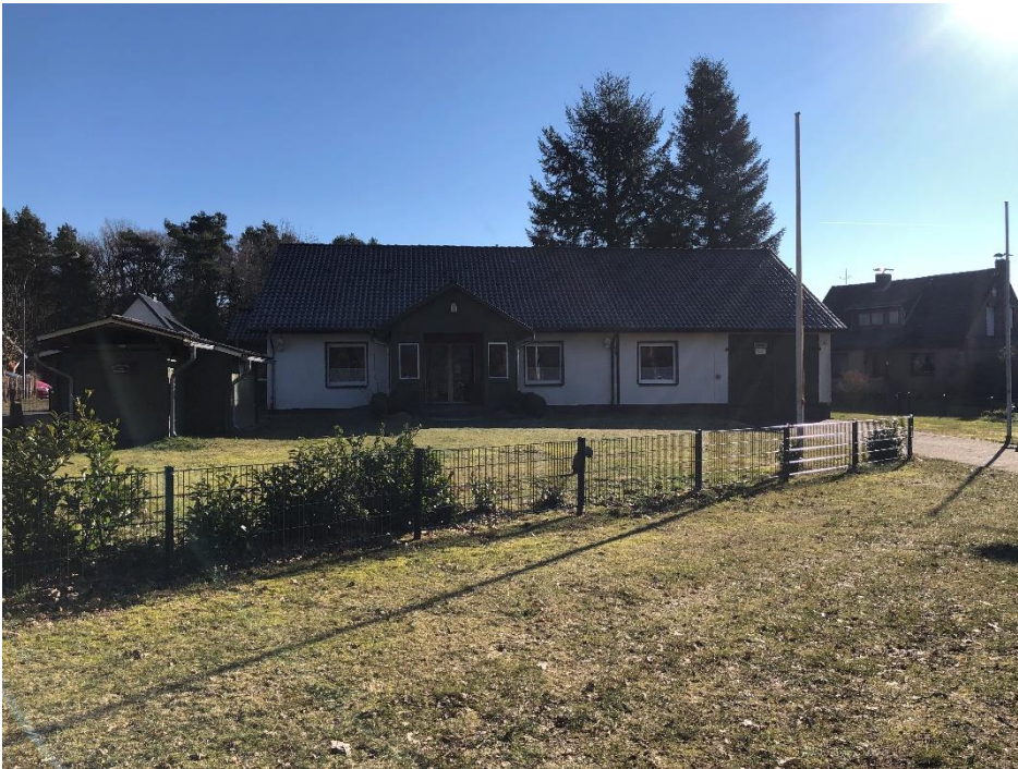
Abbildung 1: Ansicht Dorfgemeinschaftshaus, Quelle: Sweco GmbH
