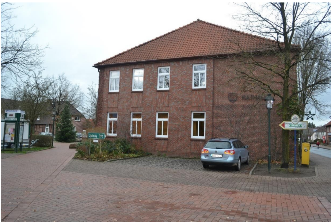
Abbildung 2: Parkplätze an Rathauseite. Quelle: Sweco GmbH
