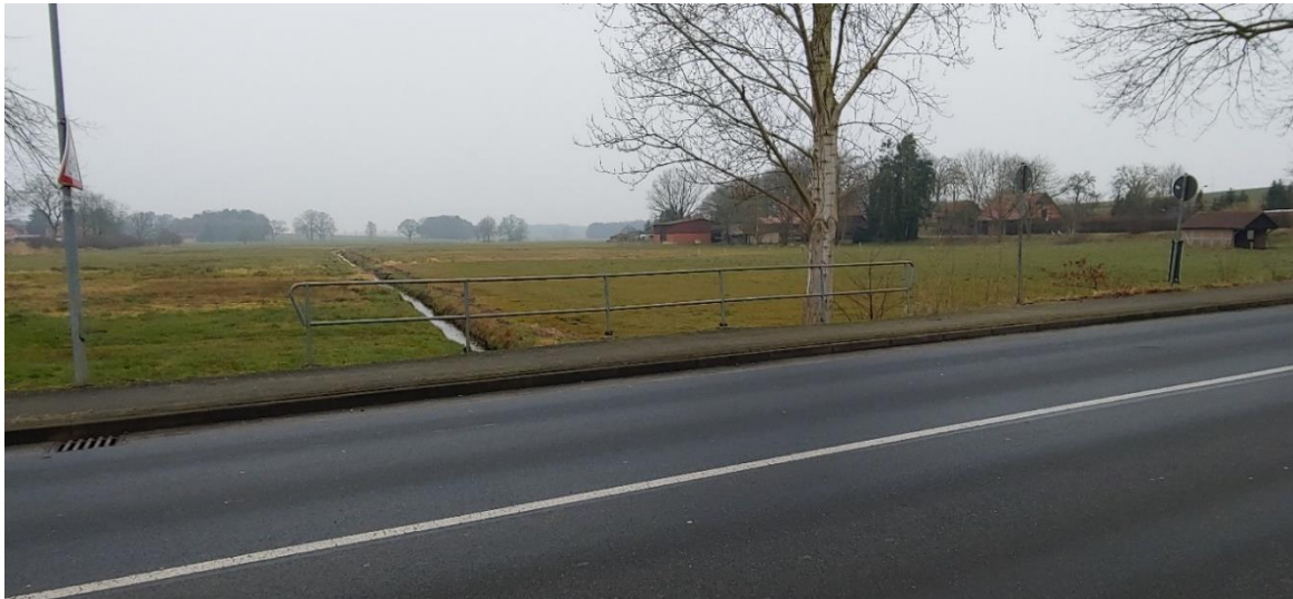
Abbildung 1: Geländer am Hasselbach. Quelle: Sweco GmbH
