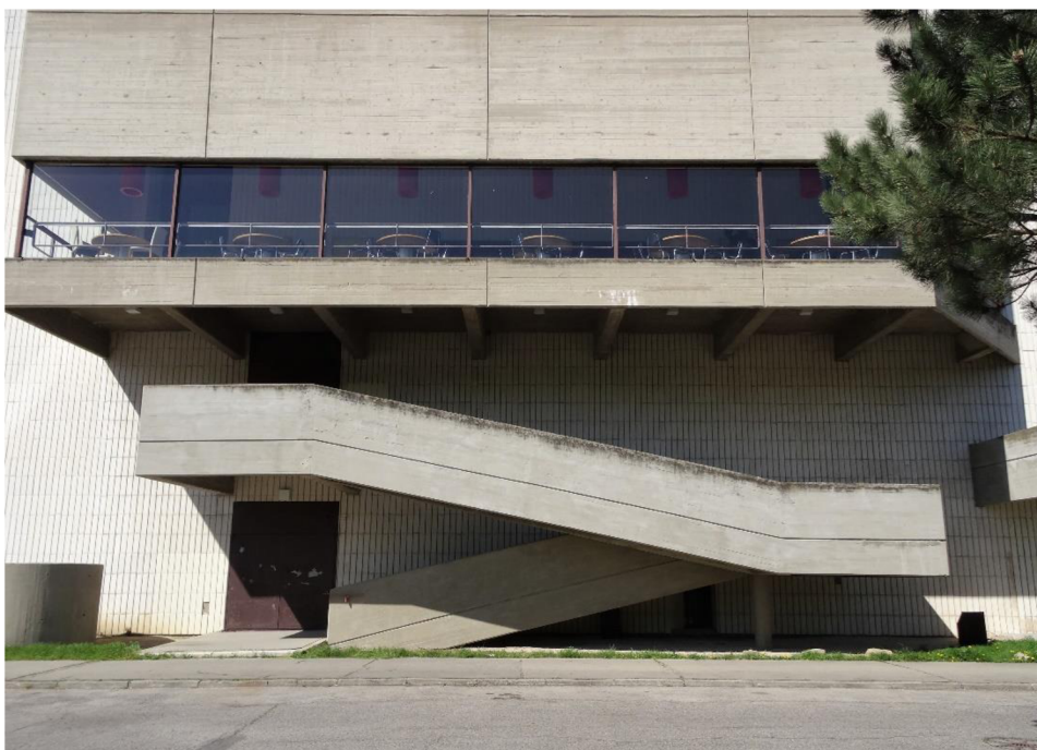
Obr. 5 Východná časť (priestor bufetu a rampa), zdroj: Janičiková P.
