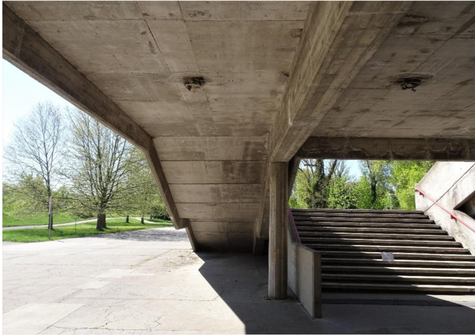
Obr. 3 Pod schodiskom, zdroj: Janičiková P.
