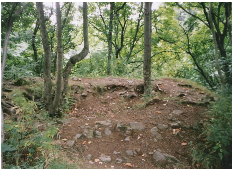
Obr. 40. Zřícenina hradu Lopata, základy věže.
