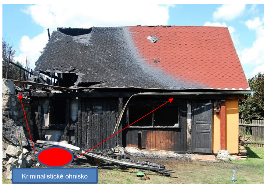
Obrázek 4 – Kriminalistické ohnisko a směr šíření požáru (vnější prostředí). Zdroj vlastní.
