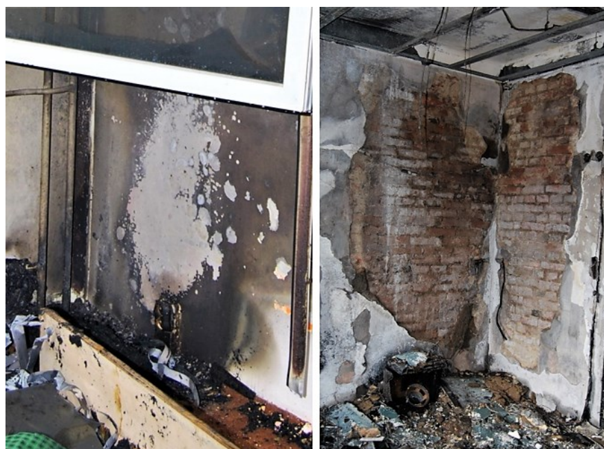
Obrázek 2 – Ohniskové příznaky nad kriminalistickým ohniskem. Zdroj vlastní.
