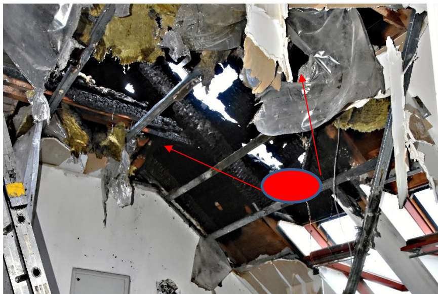
Obrázek 5 – Kriminalistické ohnisko a směr šíření požáru (uvnitř objektu). Zdroj vlastní.
