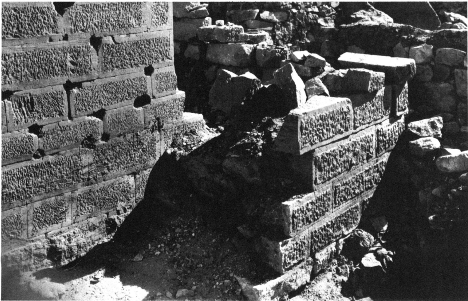
DAS BERGHEILIGTUM. A UNTERBAU DES NORDBAUS, WERKSTEIN- UND ZIEGELMAUERWERK. B SÜDWEST-ECKE VOM UNTERBAU DES NORDBAUS MIT STÜTZMAUER DER ÄLTEREN TERRASSE
