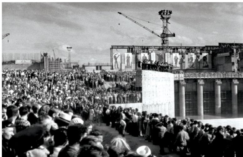
Kauno hidroelektrinės statyboje mitingas pirmosios turbinos paleidimo proga. Kaunas, 1959 m. liepos 16 d. Marius Baranausko nuotrauka
