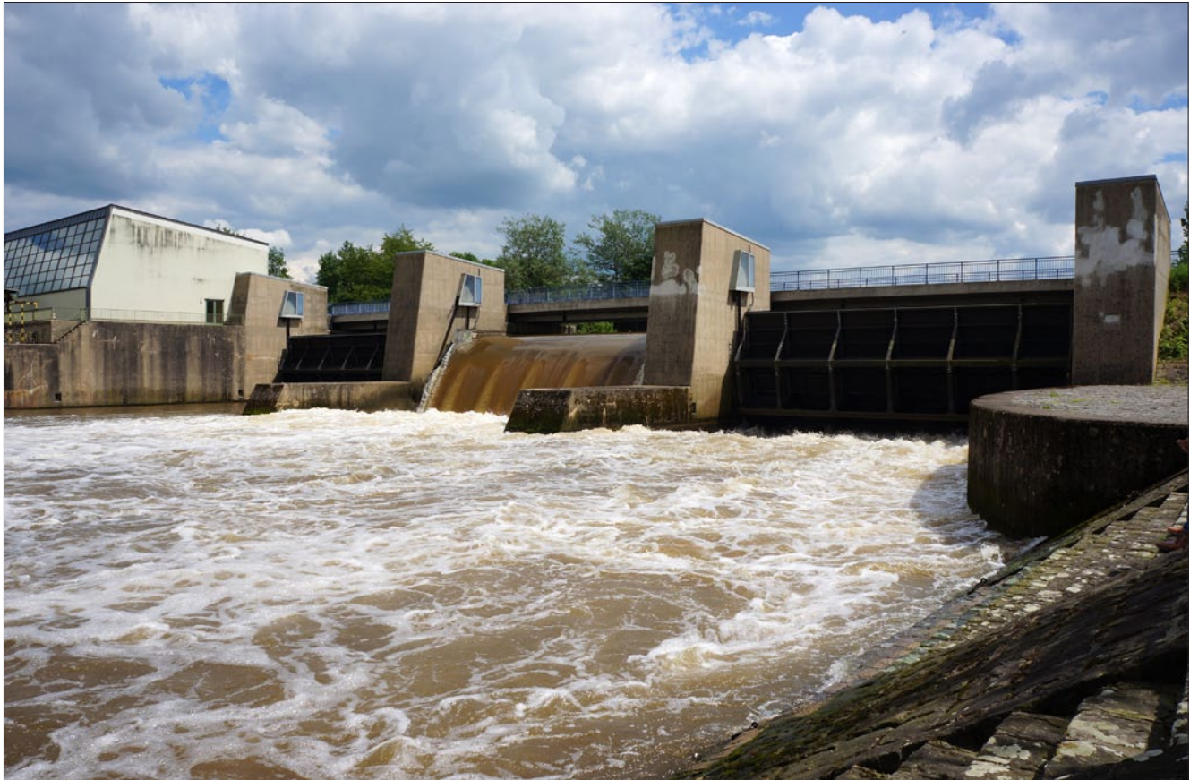
Bild 1: Staustufe Forchheim am Main-Donau-Kanal, bei der der mittlere Verschluss (Zugsegment mit Aufsatzklappe) überströmt und der rechte Verschluss (Zugsegment) unterströmt wird.
