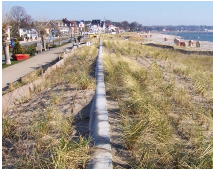
Abbildung 7: Hochwasserschutzsystem „versteckt“ im aufgeschütteten Strandwall (© Hofstede).
