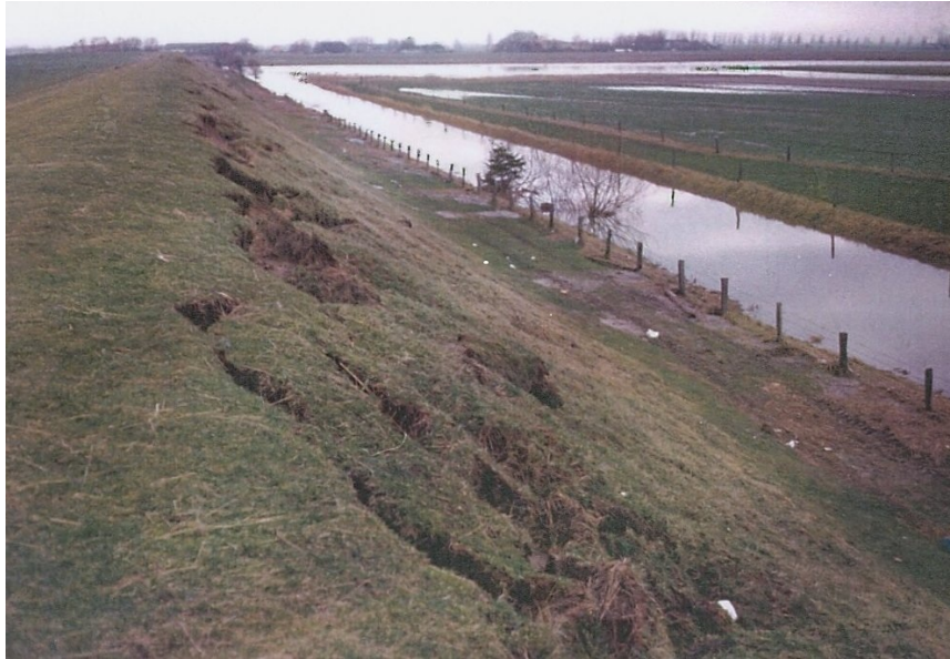
Abbildung 3: Deichbinnenböschung mit Rasenabsetzungen (Temmler und Filipinski 1997).
