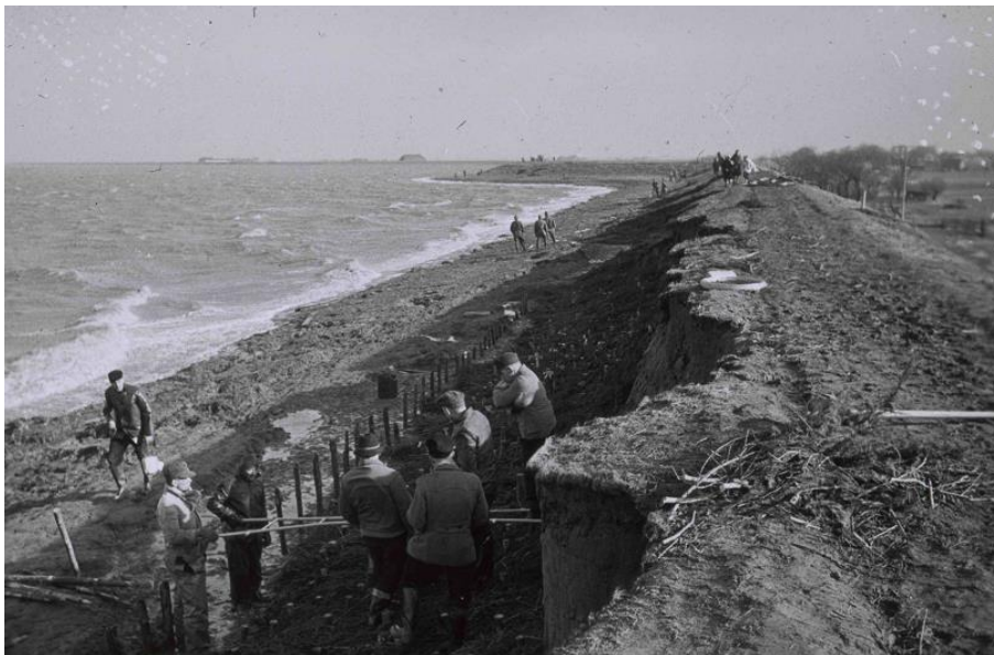
Abbildung 2: Deichaußenböschung mit Kliffbildung (Zitscher 1962).
