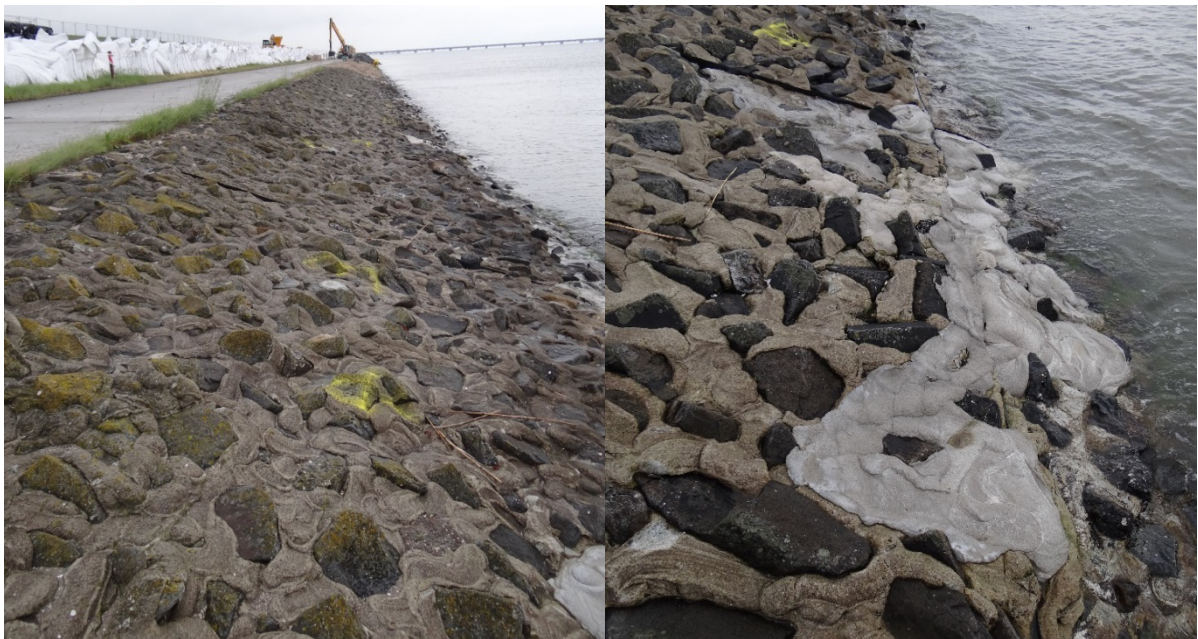
Abbildung 26: Deckwerk am Voslapper Groden (Fotos: Kreyenschulte 2016).
