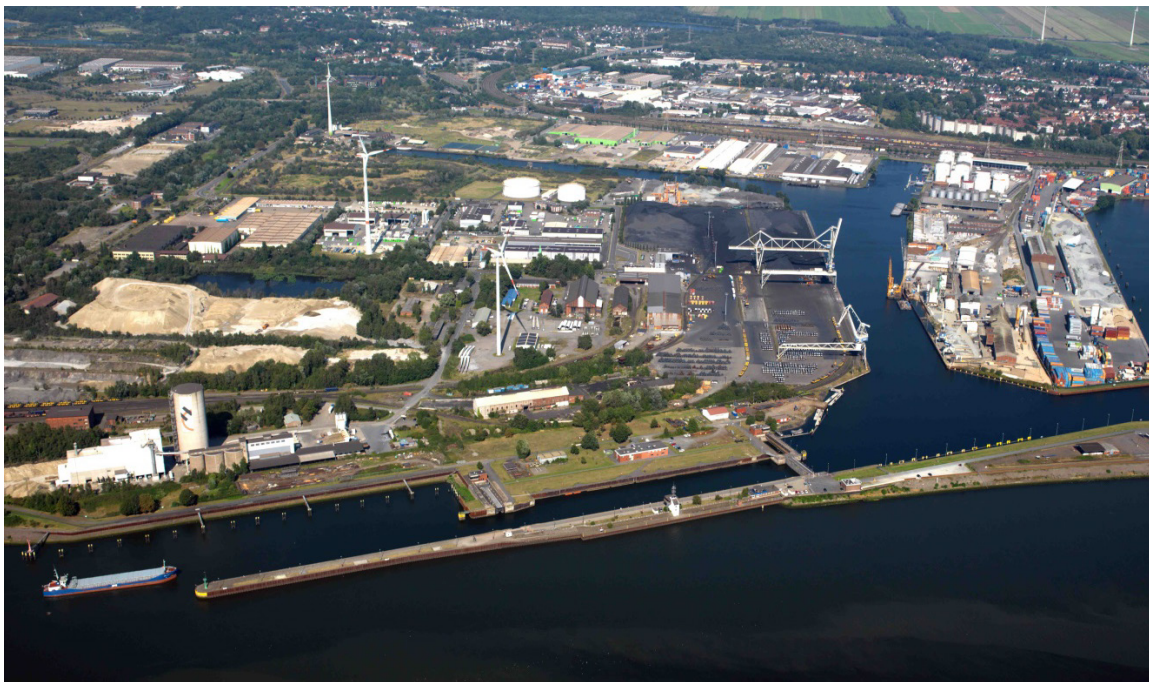
Abbildung 6: Industriehafen Bremen mit Baustelle Kajenrückverlegung (Mitte rechts). Quelle: bremenports GmbH & Co. KG.
