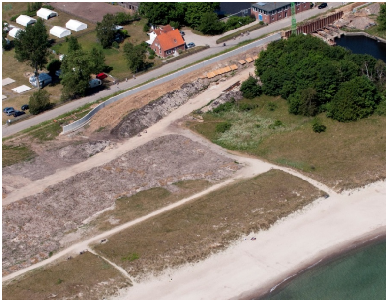
Abbildung 5: Bau einer Hochwasserschutzwand auf dem Landesschutzdeich Dahme-Rosenfelde (© LKN.SH).
