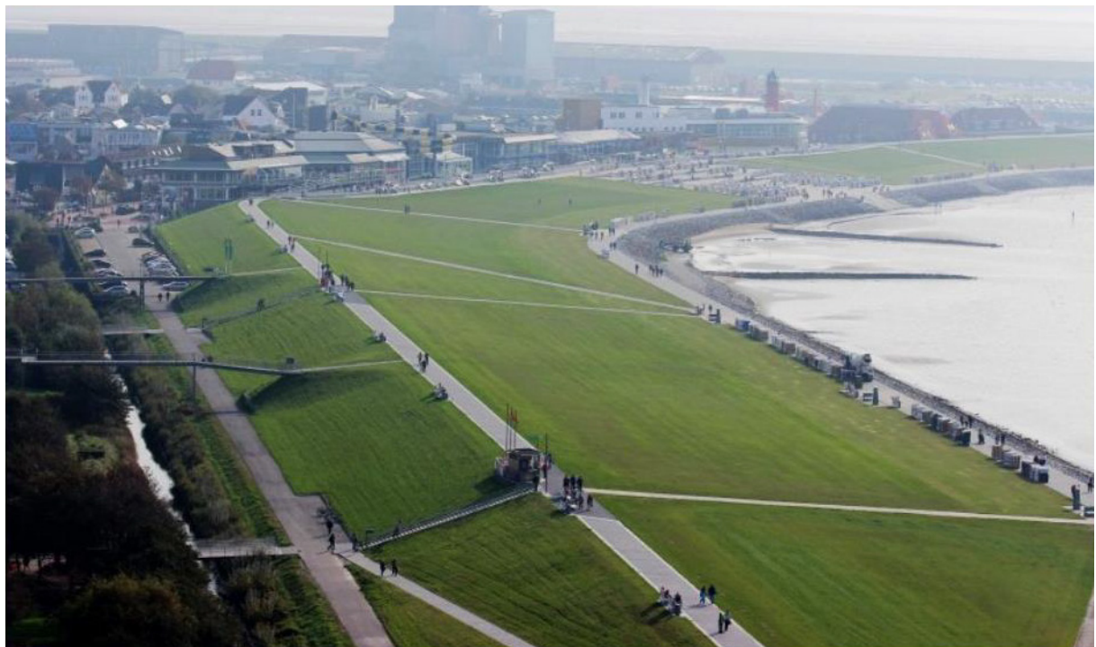
Abbildung 8: Landesschutzdeich in Büsum nach der Verstärkung (© LKN.SH).
