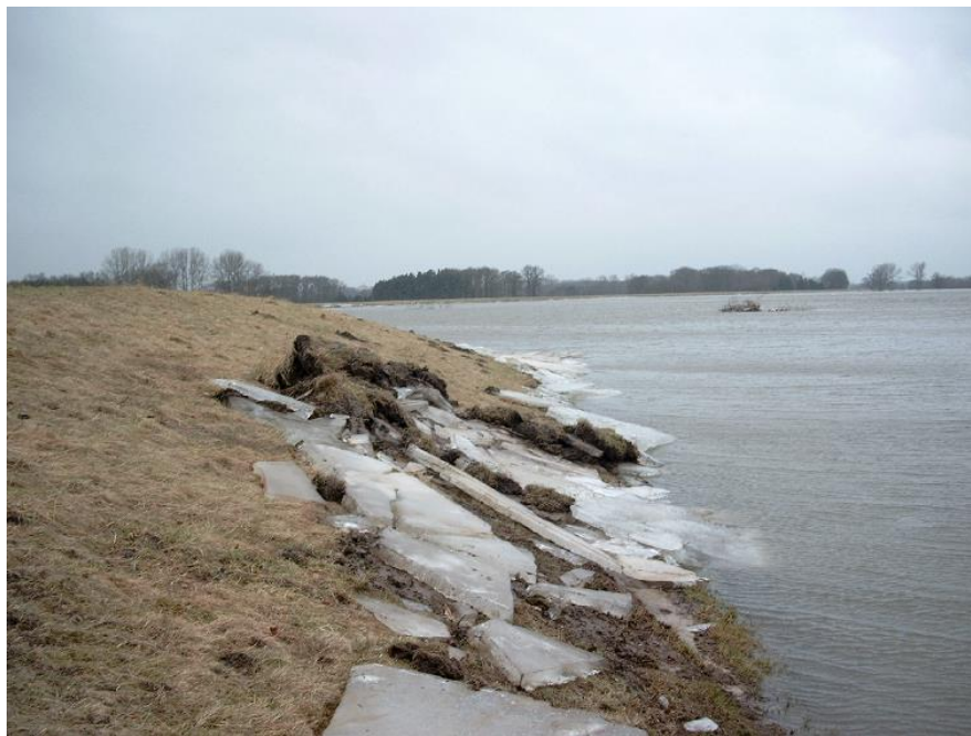
Abbildung 6: Zerstörung der Grasnarbe an der Deichaußenböschung durch Eisdrift.
