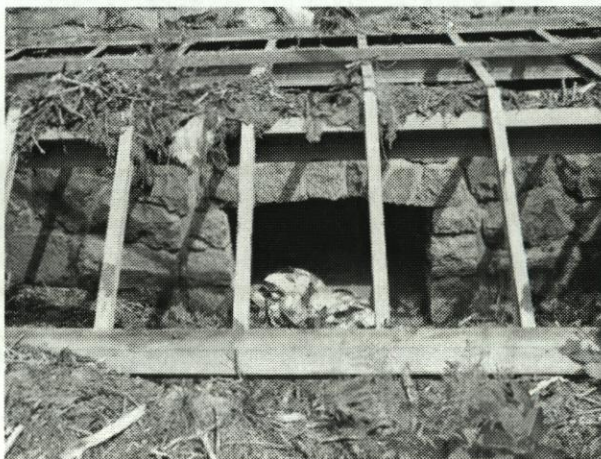
Abbildung 7 Einlauf des Durchlasses beräumt (Foto: Gilli 2003)
