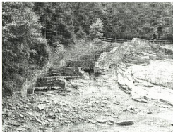
Abbildung 5 Hochwasserentlastungsanlage von Unterwasser, nördliche Bruchfläche (Foto: Bornschein)
