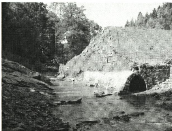
Abbildung 4 Dambruchstelle mit Durchlass von Unterwasser, nördliche Bruchfläche (Foto: Bornschein)
