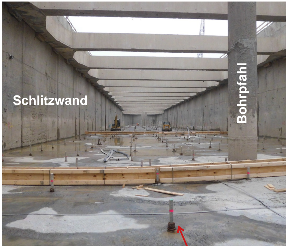
Baugrube Schleuse Zerben
