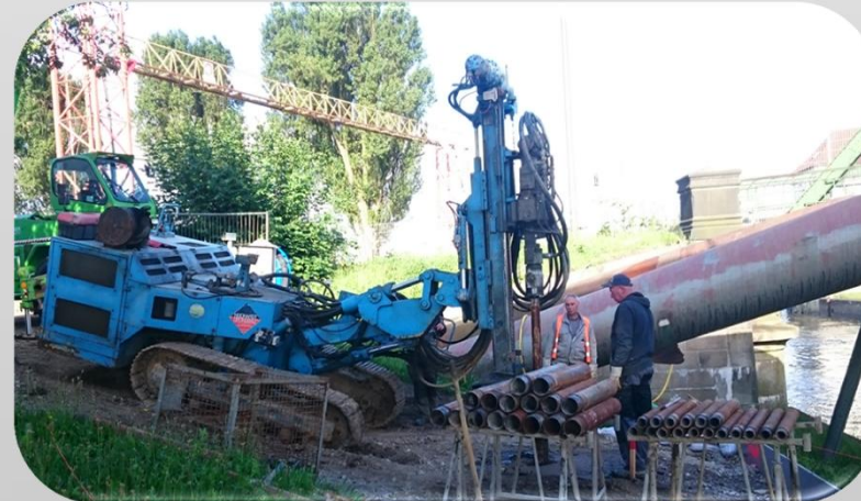
Einfach verrohrte Drehspülbohrung
