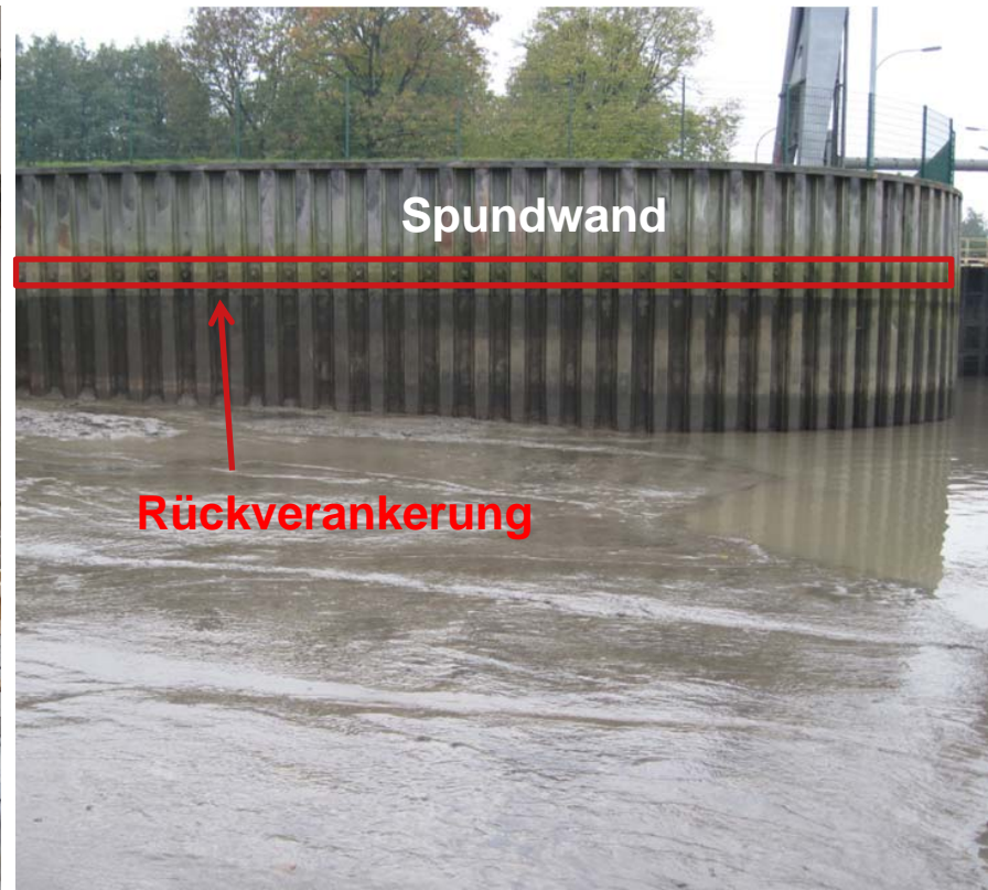
Vorhafen Schleuse Herbrum
