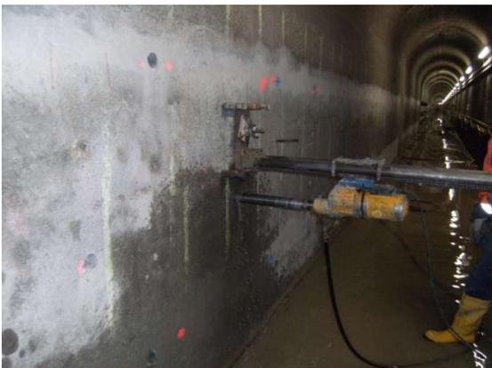
Bild 41: Kernbohrgerät
