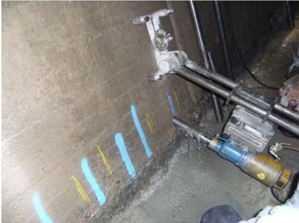
Bild 45: Bohrständer mit Kernbohrgerät
