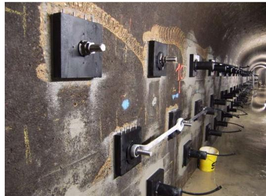
Bild 11: Kugelbundmutter auf Ankerplatte
