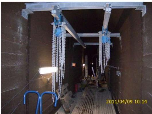
Bild 30: Kranbahn und Brücke über Zulauf
