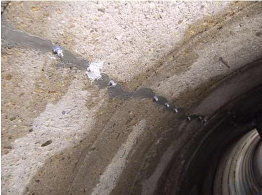
Bild 43: Packer zur Rissverpressung
