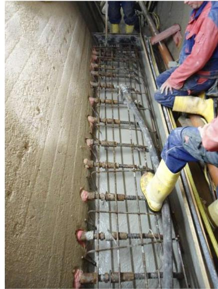
Bild 46: Betonage Stufe
