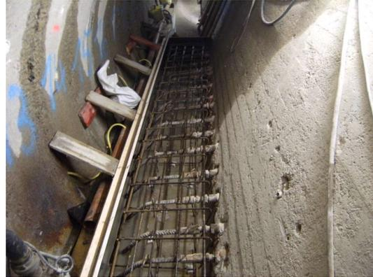
Bild 21: Stufe vor Betonage
