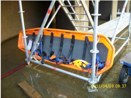
Bild 47: Schleifkorbtrage
