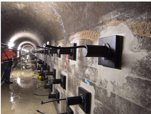
Bild 10: Ankerplatte mit Abdeckkappe
