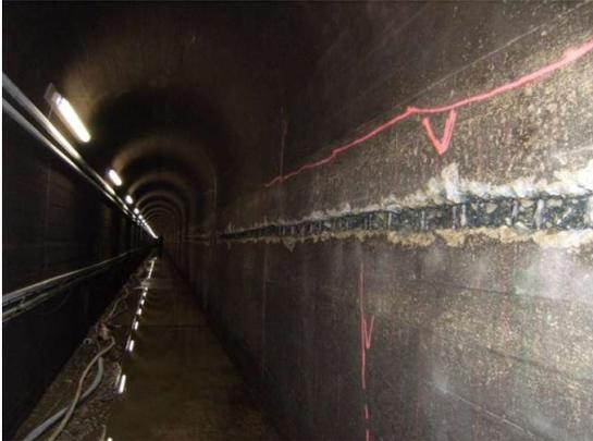
Bild 39: Bewehrung im Suchschlitz
