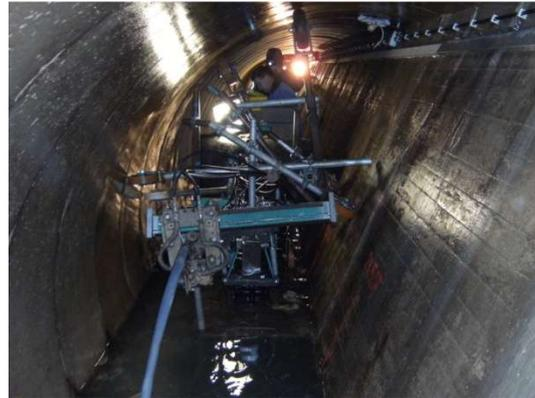
Bild 44: HDW-Roboter im Drainagegang
