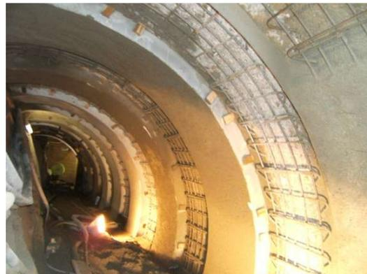
Bild 15: Abschnittsweise Betonage
