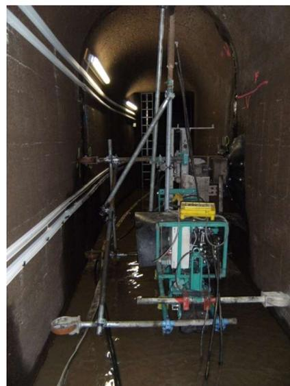
*Bild 38: HDW-Roboter für Suchschlitz*
