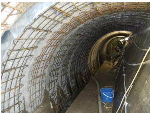
Bild 14: Bauteilertüchtigung Drainageringe
