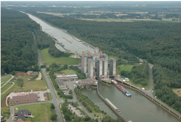
Abbildung 3: Schiffshebewerk Lüneburg bei Scharnebeck
