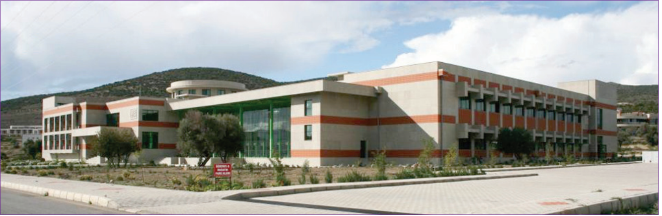
Şekil 1. İzmir Yüksek Teknoloji Enstitüsü (İYTE), Makine Mühendisliği Fakültesi binası, İzmir.
