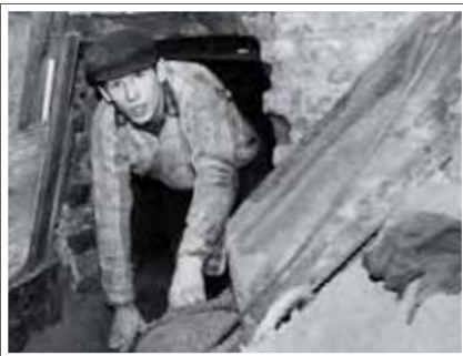
地下トンネル ブレーノ・ベッカーは、壁の下にトンネルを掘ることを考えた 最初のベルリン市民のひとりである。1962年1月30日、彼の家族をはじめ 28人が、脱出のチャンスをもにした。
