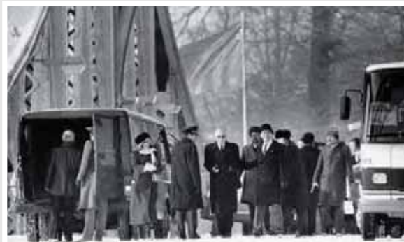
最後のスパイ交換となった冬 1986年2月11日の3回目の交換が、グリーニッカー橋を介した最後の交換となった。東側は、高名な市民運動家ナタン・シャランスキーを解放した。
