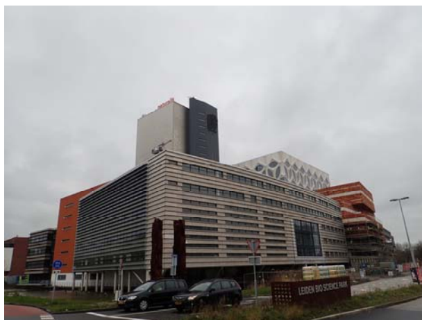
工事中のナチュラリス本館
