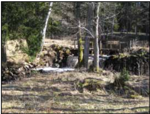
FIGUR 2. RAÄ Barkeryd 170:1, kvarnlämning, bestående av en kvarnbyggnad (utanför bild) samt en dammvall, kallmurad av gråsten med två luckor.
