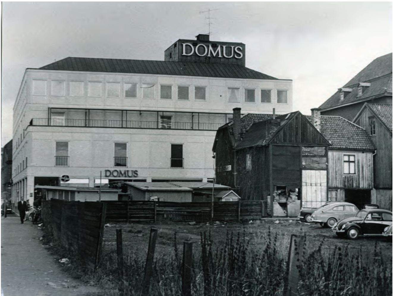
FIGUR 80. Kvarteret Apeln rivs för att ge plats åt Domus-parkeringen i slutet på 1950-talet. Notera de fallfärdiga husen till höger. JLM 89/2:2141.
