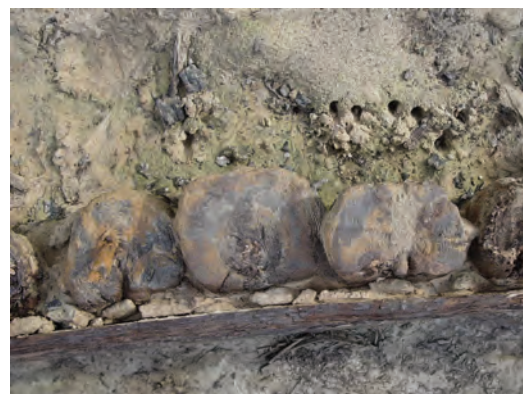
FIGUR 225. Den täta pålning som utfördes på tomt 34 för att säkra husen och utfyllnaderna.
