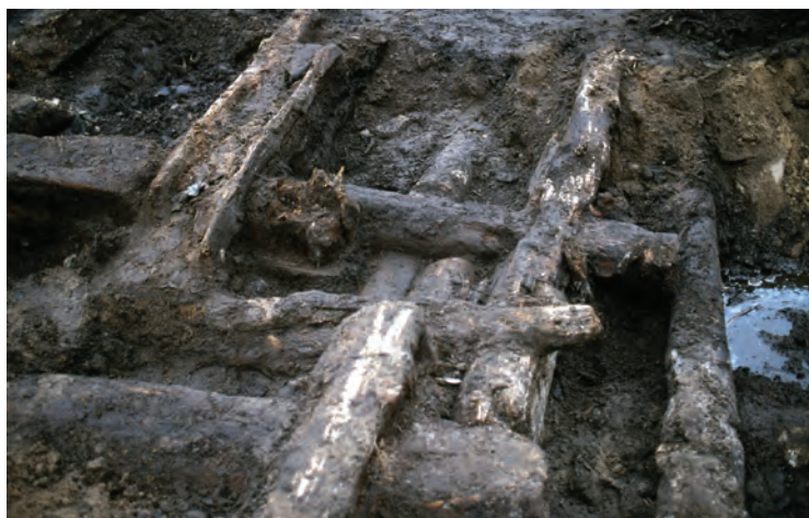
FIGUR 240. Detalj från trækistorna som visar hur de fogats samman.
