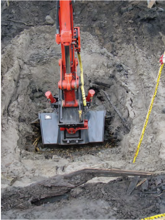
FIGUR 11 OCH 12. Grävmaskinen var en ovärderlig hjälp både vid mätning och borttagande av stora mängder massor.
