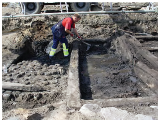
FIGUR 131. Kajen inom tomt 35 - två rader kraftigt timmer med en mellanliggande fyllning.
