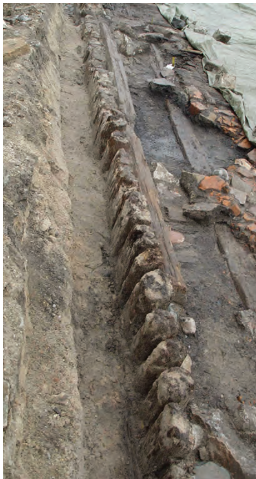
FIGUR 130. Den täta pålning som man vid mitten av 1810-talet tvingades placera ut längs tomt 34 södra del som ett skydd mot vågor och framför allt isskruvning.
