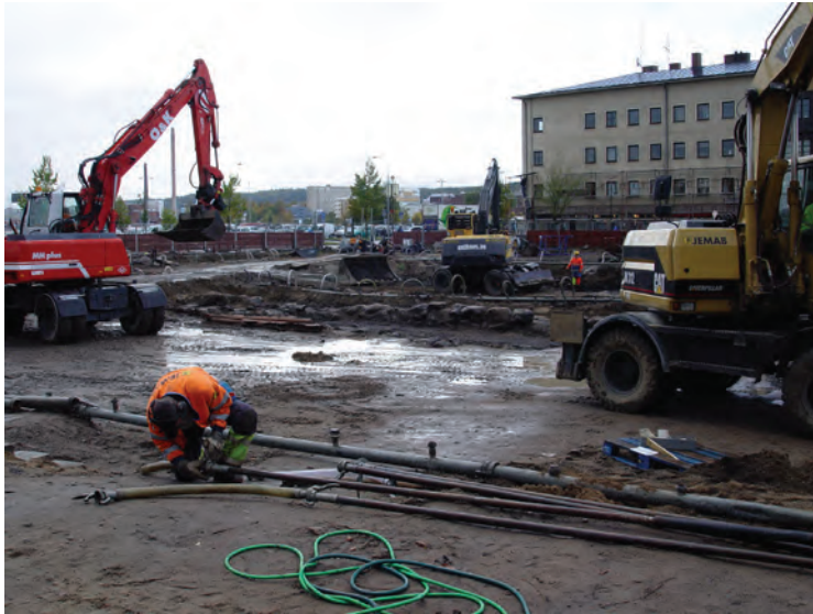
FIGUR 20 OCH 21. Wellpointsystemet placeras ut sommaren 2004 och visar sig fungera utmärkt! På den nedre bilden är rören monterade längs med den västra sidan av tomt 35.
