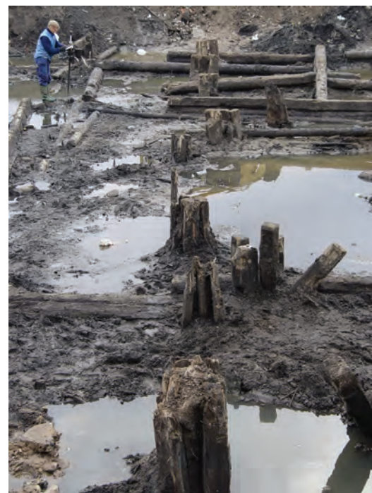
FIGUR 94. Grupper med tre till fyra pålar som placerats under 1800-talshusens bärande punkter i tomt 38.
