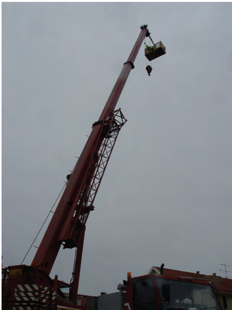
FIGUR 27. Fotodokumentation med hjälp av mobilkran med 30 meter lång arm.
