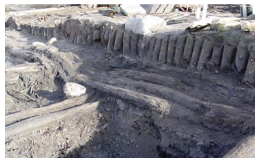
FIGUR 57. Pålning av tätt ställda stolpar som bär husgrunden på den sida som vätter mot vreten. Gård 36.
