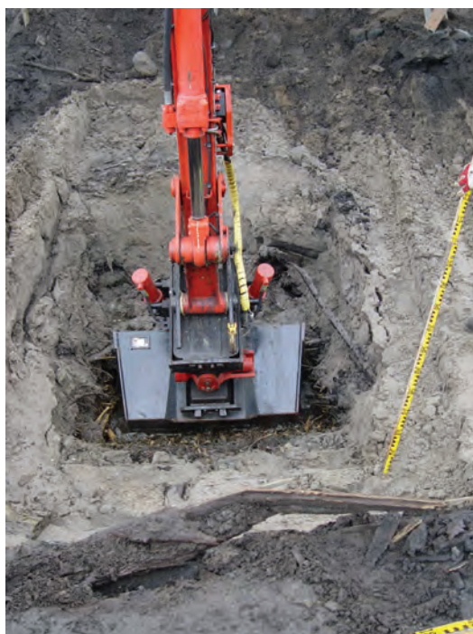
FIGUR 89. Fyllningen i de träkistor, som varit förutsättningen till ny mark, utgjordes av avfall, sand och granris.
