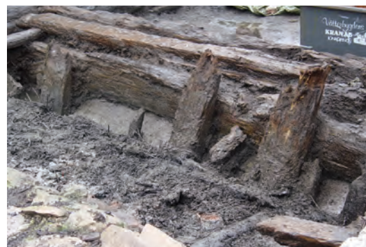
FIGUR 129. En temporär kajkant i tomt 34, en tillfällig lösning i väntan på fortsatt utbyggnad.
