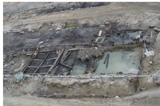
Figur 132. Den i söder liggande oavslutade byggnadsetappen inom tomt 35, med pålrader och liggtimmer men där timmerkistorna aldrig placerades ut.
