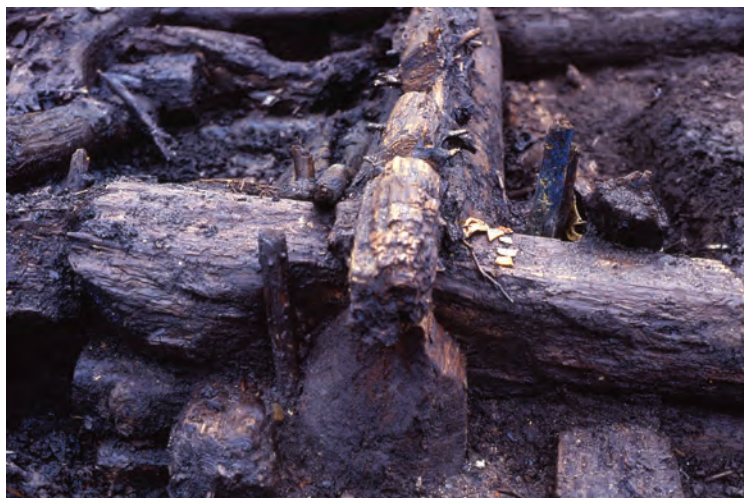
FIGUR 145. Byggnadsdetalj inom Hus 2 med stöttor för knuten på både insidan och utsidan.
