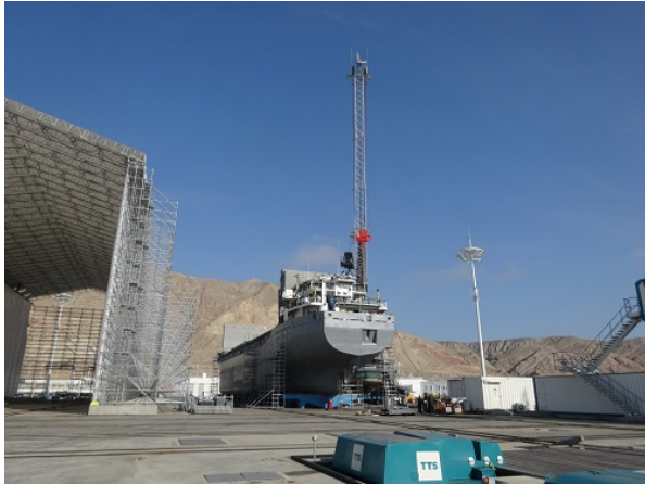
船舶の修理場 (同時に4隻、年間20~30隻まで修理可能)
