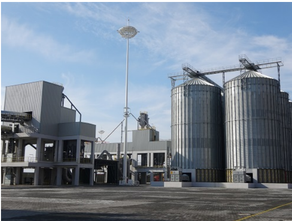
穀物ターミナル (運搬はデジタルモニタリングされている)
