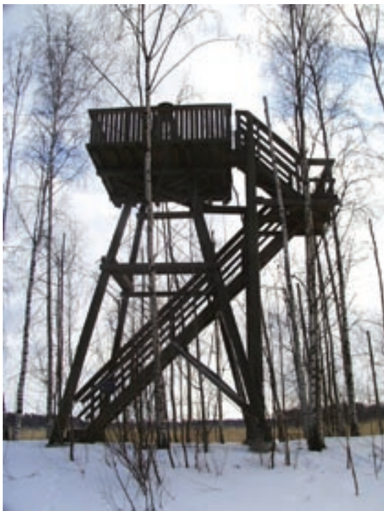
Viikin-Vanhankaupunginlahden Pornaistenniemen lintutornin portaikko on erillään lintutornista vakauden lisäämiseksi. Kuva: Mikko Yletyinen.
