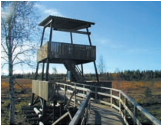
Alkunkarin lintutornin alataso soveltuu myös liikuntaesteisille ja ylätaso antaa suojan sateella. Ylätason katos on turha, sillä se rajoittaa näkyvyyttä. Kuva: Reijo Kallioniemi.
