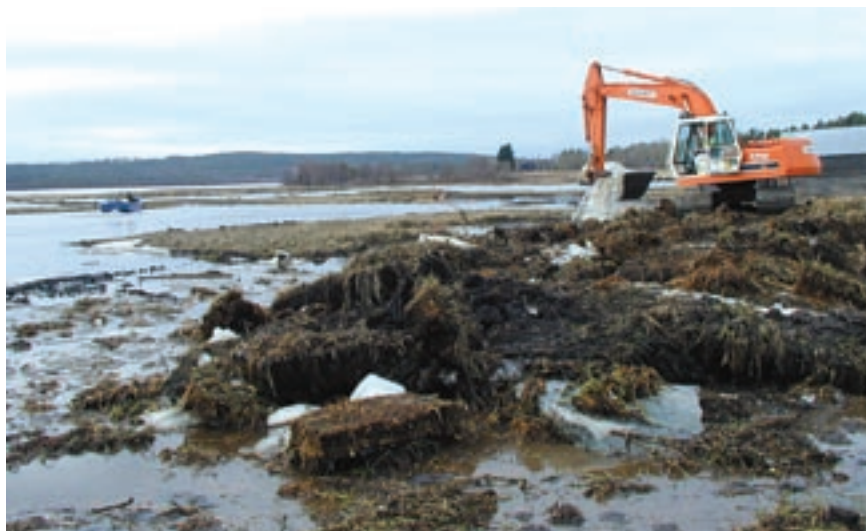
Sulan veden aikana turvelauttapalat vedettiin vaijerin avulla rantaan, läjitettiin kuivumaan ja maisemoitiin Vähä-Meltosjärven rannalle. Kuva: Reijo Kallioniemi.
