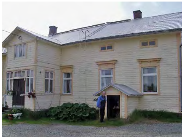
Kuva 48. Päärakennuksen toinen pää. LKYT 2006.
