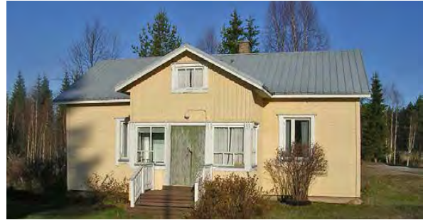
Kuva 43. Mäkelän päärakennus. LKYT 2006.
