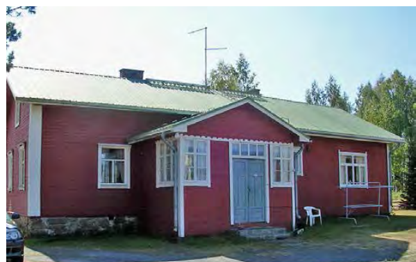
Kuva 86. Kuuselan päärakennus. LKYT 2006.
