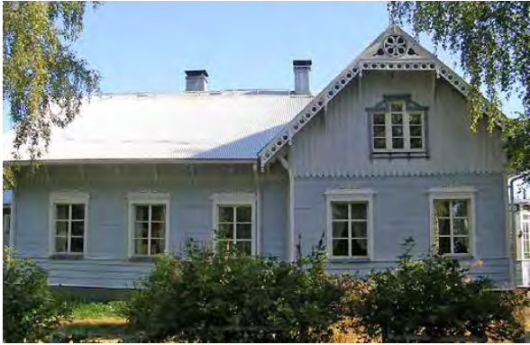
Kuva 89. Mansikkaniemen päärakennus. LKYT 2006.
