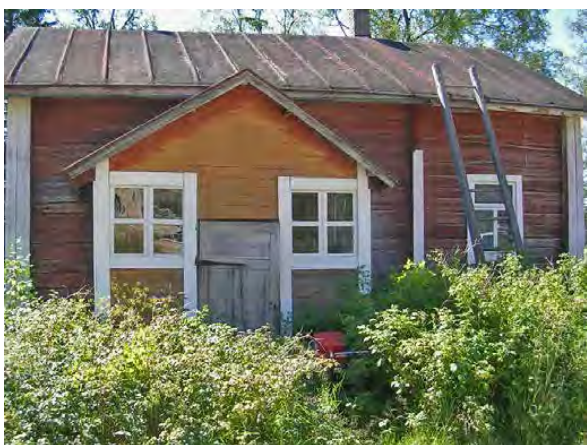
Kuva 66. Onkalon vanha torppa on 1800-luvun alkupuolelta. LKYT 2006.
