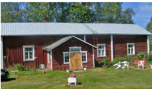
Kuva 123. Apulan päärakennus. LKYT 2006.
