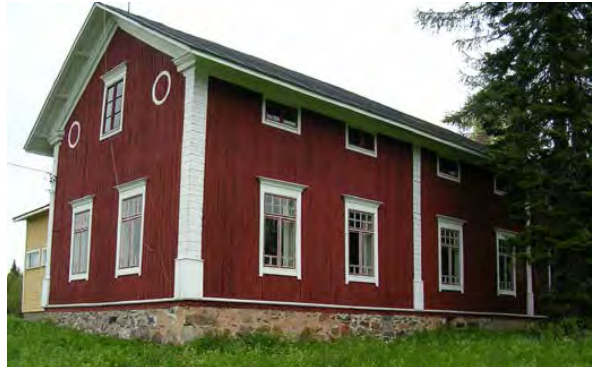
Kuva 60. Ervastin pääty- ja takajulkisivua. LKYT 2006.
