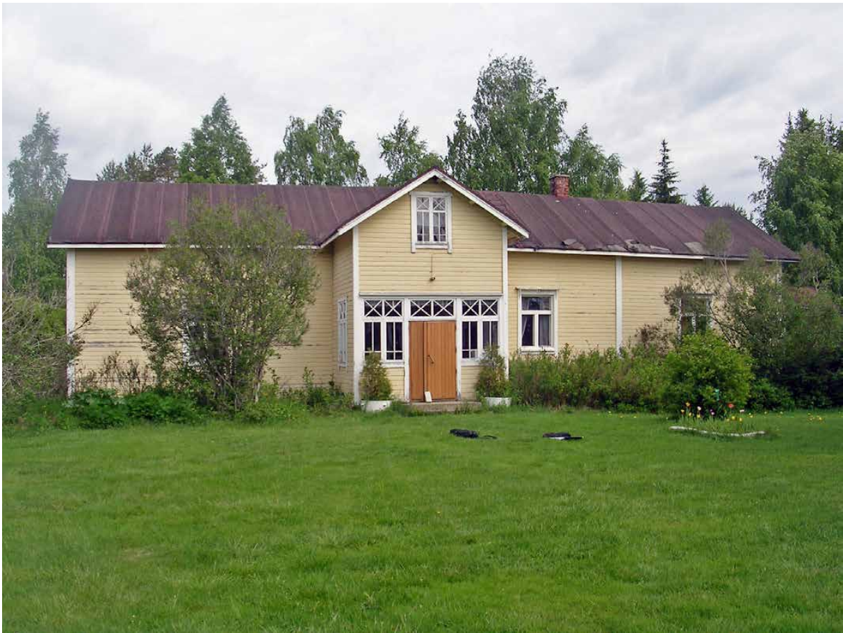
Kuva 129. Lehtolan päärakennus. LKYT 2006.
