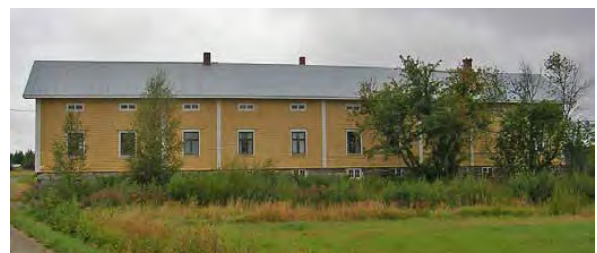
Kuva 93. Päärakennuksen takajulkisivu. LKYT 2006.
