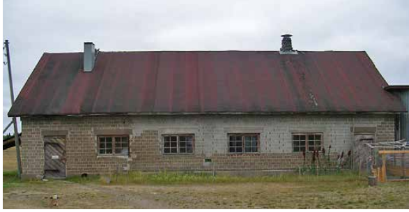
Kuva 126. Pihlajaojan tiilinavetta. LKYT 2006.
