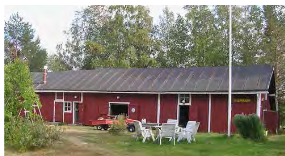
Kuva 64. Erikarin navettarakennus. LKYT 2006.
