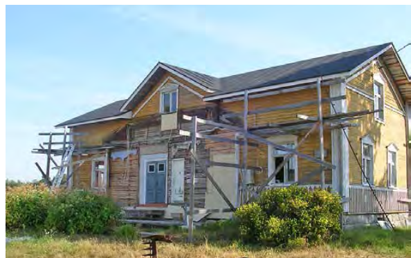
Kuva 100. Joki-Eskolan päärakennus remontin aikana. LKYT 2006.
