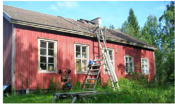
Kuva 151. Ylipään koulurakennusta on remontoitu. LKYT 2007.
