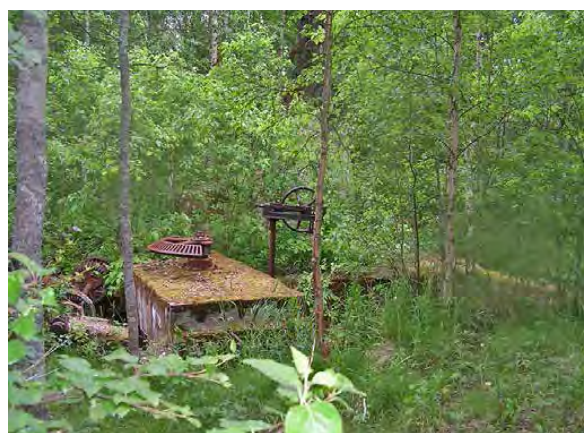
Kuva 165. Saarikosken sahan perustuksia Saarikosken partaalla. Maisemassa maatuivat rakennelmat ovat muuttumassa teollisuushistorialliseksi jäännökseksi. LKYT 2007.
