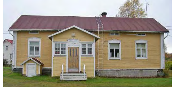
Kuva 76. Kylmälän päärakennus. LKYT 2006.
