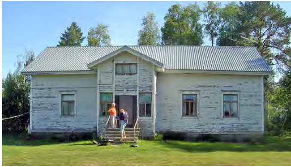
Kuva 34. Keskitalon päärakennus. LKYT 2007.
