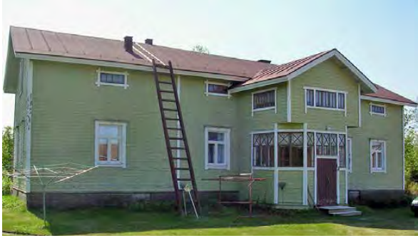
Kuva 36. Huhtalan päärakennus. LKYT 2006.
