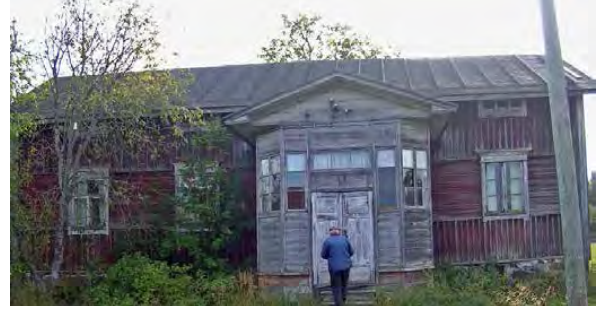
Kuva 72. Uusi-Vallon vanha päärakennus. LKYT 2006.
