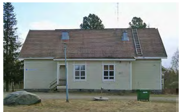
Kuva 146. Viantien vanhempi koulurakennus. LKYT 2006.
