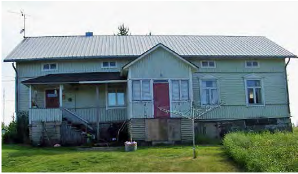
Kuva 46. Postin päärakennus. LKYT 2006.
