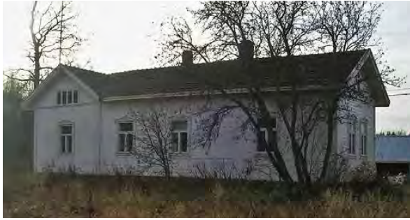
Kuva 91. Keskifilpuksen päärakennus. LKYT 2006.
