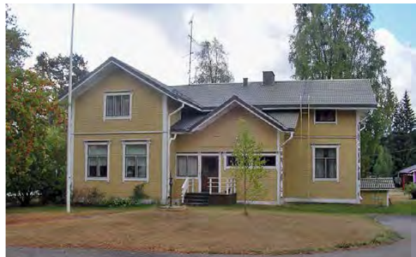
Kuva 27. Penttilän päärakennus. LKYT 2006.
