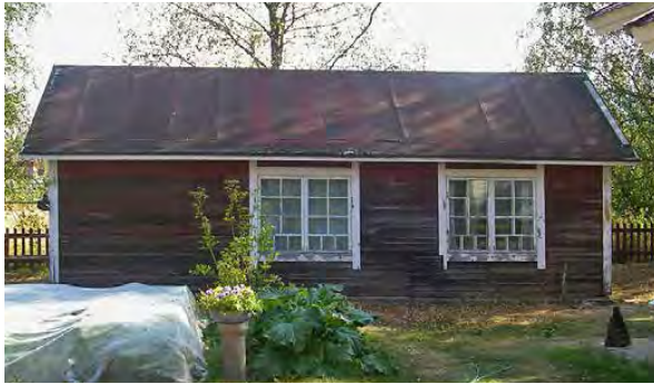
Kuva 113. Entisessä kanalarakennuksessa on hienot jugendhenkiset ikkunat. LKYT 2006.
