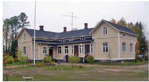
Kuva 24. Lempilän päärakennus. LKYT 2006.
