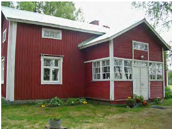
Kuva 127. Huhdan päärakennus. LKYT 2006.
