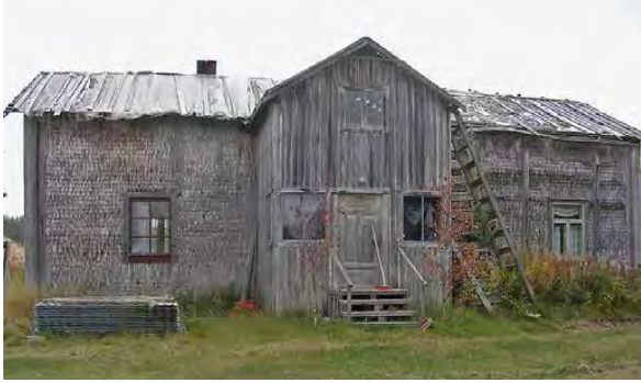
Kuva 32. Vainionpään päreillä vuorattu vanha asuinrakennus. LKYT 2006.
