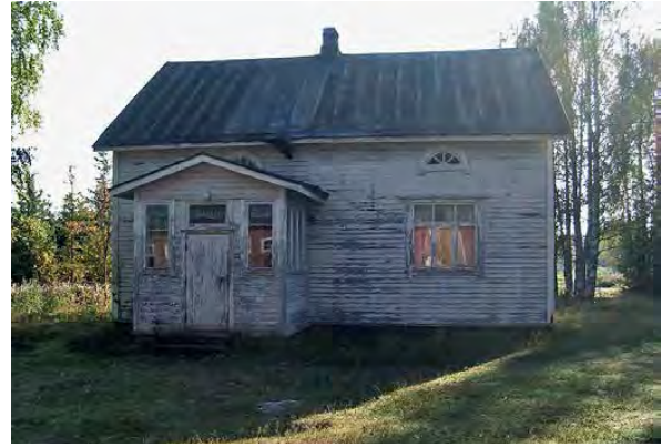
Kuva 41. Lehtolan päärakennus. LKYT 2006.
