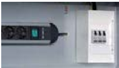
Abb.: Verteilerkasten, Schutzklasse IP30 mit Einzelphasen-Absicherung
